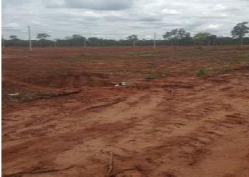
Figura 15. Vista da rede de distribuição de energia elétrica custeada e edificada pela Energisa (Fonte: Processo judicial nº. 0000292-21.2013.8.12.0001, p. 904)
