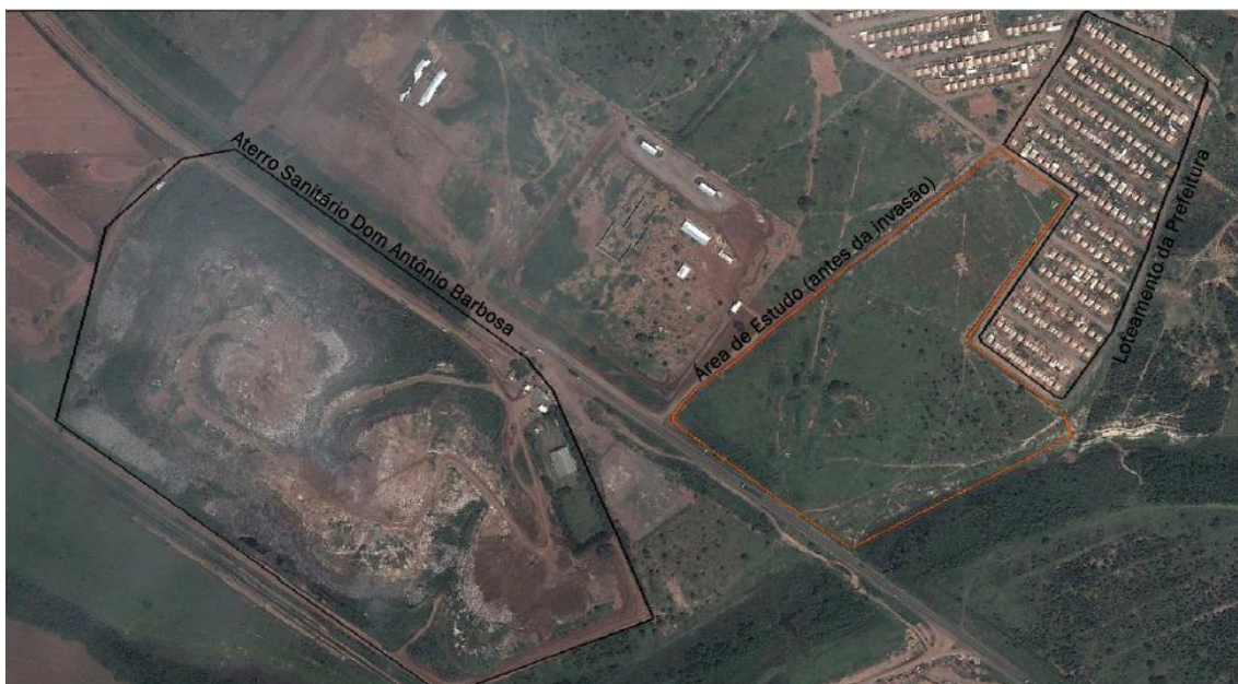
Figura 10. Vista aérea dos Lotes n°. 02 e n°. 03 em 20/12/2012 (pré-ocupação) (Fonte: figura obtida através do aplicativo Google Earth)
