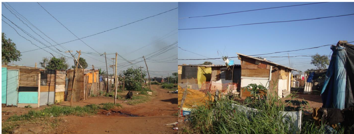
Figura 13. Estruturas destinadas à moradia atendidas por rede e ligações clandestinas (Fonte: Imagens cedidas pelo Grupo Energisa)
