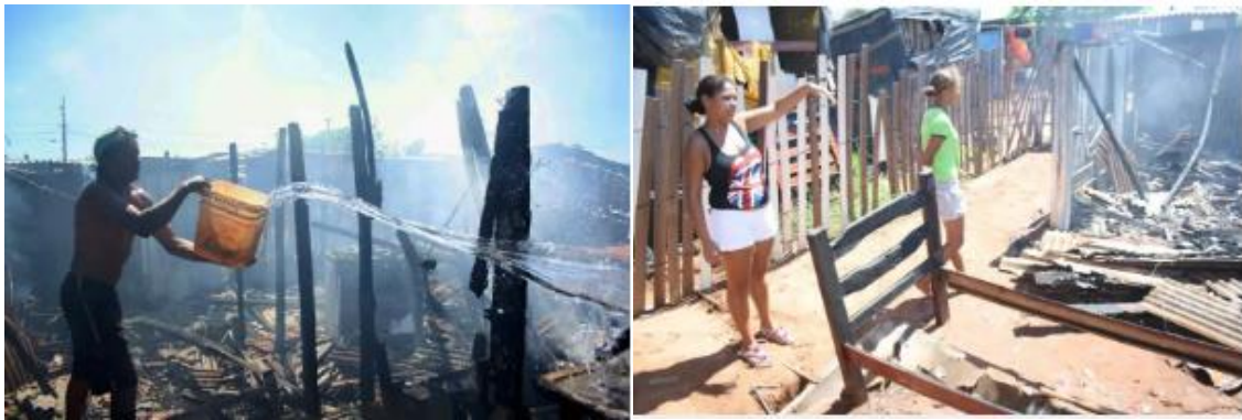
Figura 14. Estrutura destinada à moradia destruída por incêndio provocado por curto-circuito na rede elétrica clandestina (Fonte: Homepage do jornal eletrônico Campo Grande News) 27
