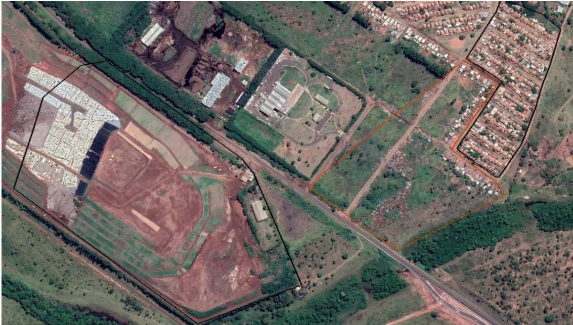
Figura 16. Vista aérea do Lote n°. 02 em 14/05/2020 (Fonte: Figura obtida através do aplicativo Google Earth)
