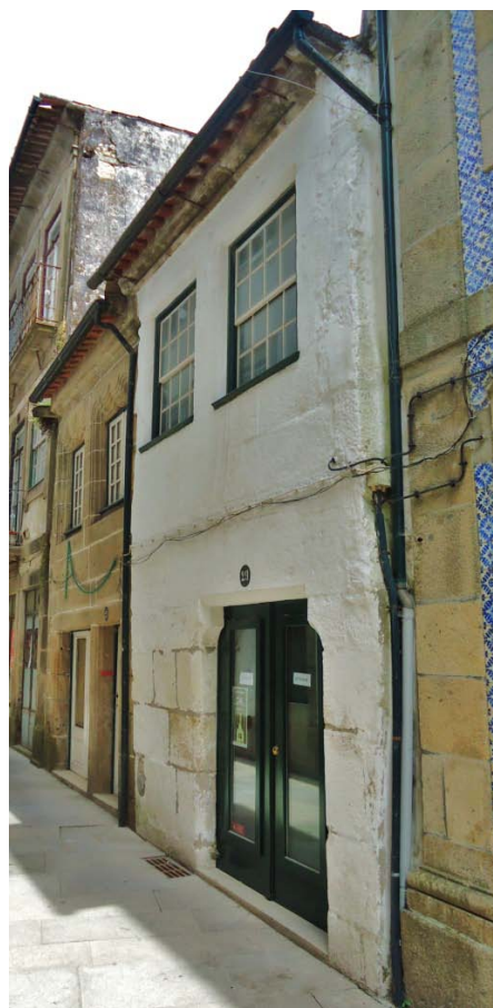
63 - a casa nº 29 da rua Beato Francisco Pacheco (rua de Sanhoane) é a única que conserva uma fachada indubitavelmente anterior ao Censo de 1535
