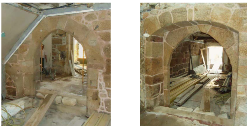
100 –As duas faces de um dos arcos quebrados que se acharam na casa intervencionada, reconhecendo-se o soterramento parcial, ainda mais acentuado no segundo arco
