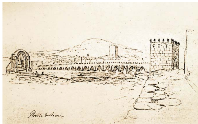
52 - Desenho antigo do início do séc. XIX (col. particular), que mostra a face norte da Torre Velha, com três troneiras no adarve, reduzindo a torre, assim, a três pisos e não a quatro
