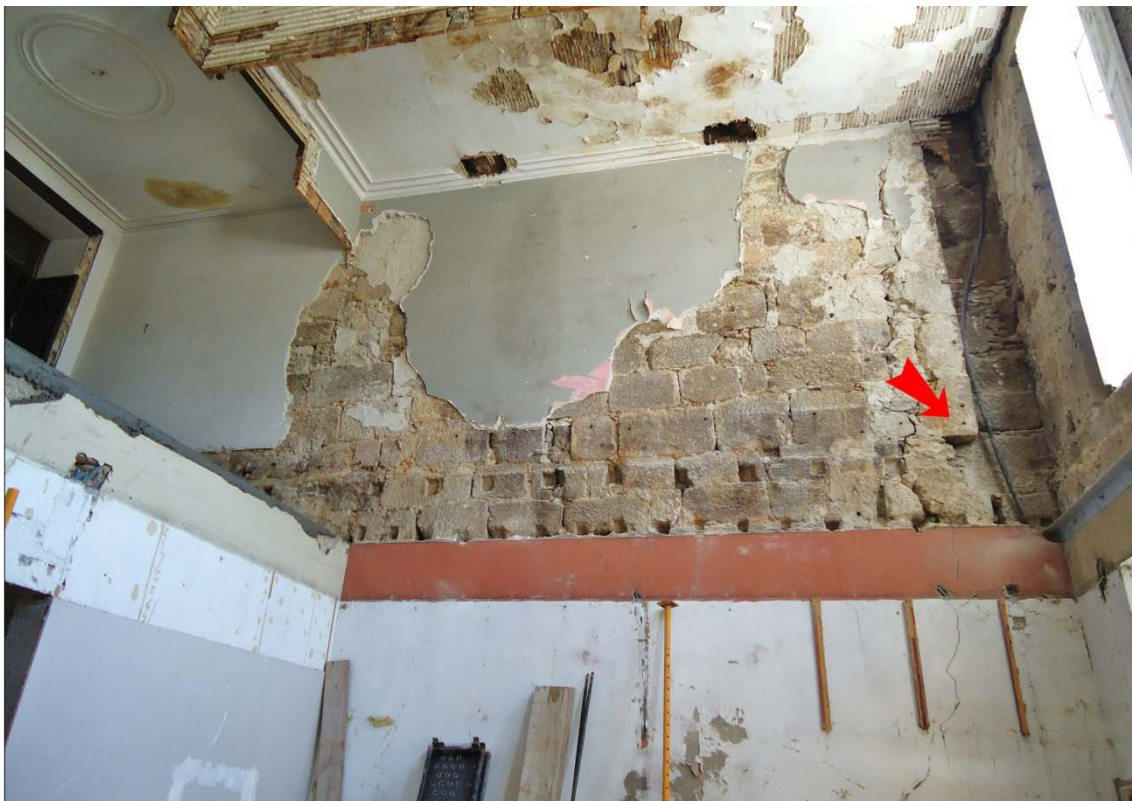
98 – Nesta fotografia da parede sul do edifício, ainda na fase da investigação, antes do início da obra, é bem perceptível, até pela diferença do aparelho da elevação, a justaposição da Torre do Patim sobre uma parede mais antiga, tal como refere o Tombo da Gafaria. A seta vermelha assinala o contafiamto da primeira fiada do cunhal noroeste da torre, que se conserva intacto.
