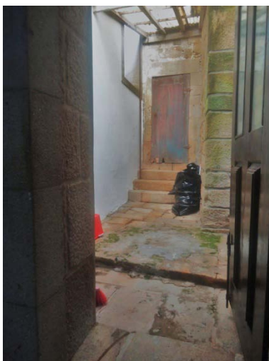
77 – Vestígios da rua da Fraria junto à capela-mor da igreja da Misericórdia
