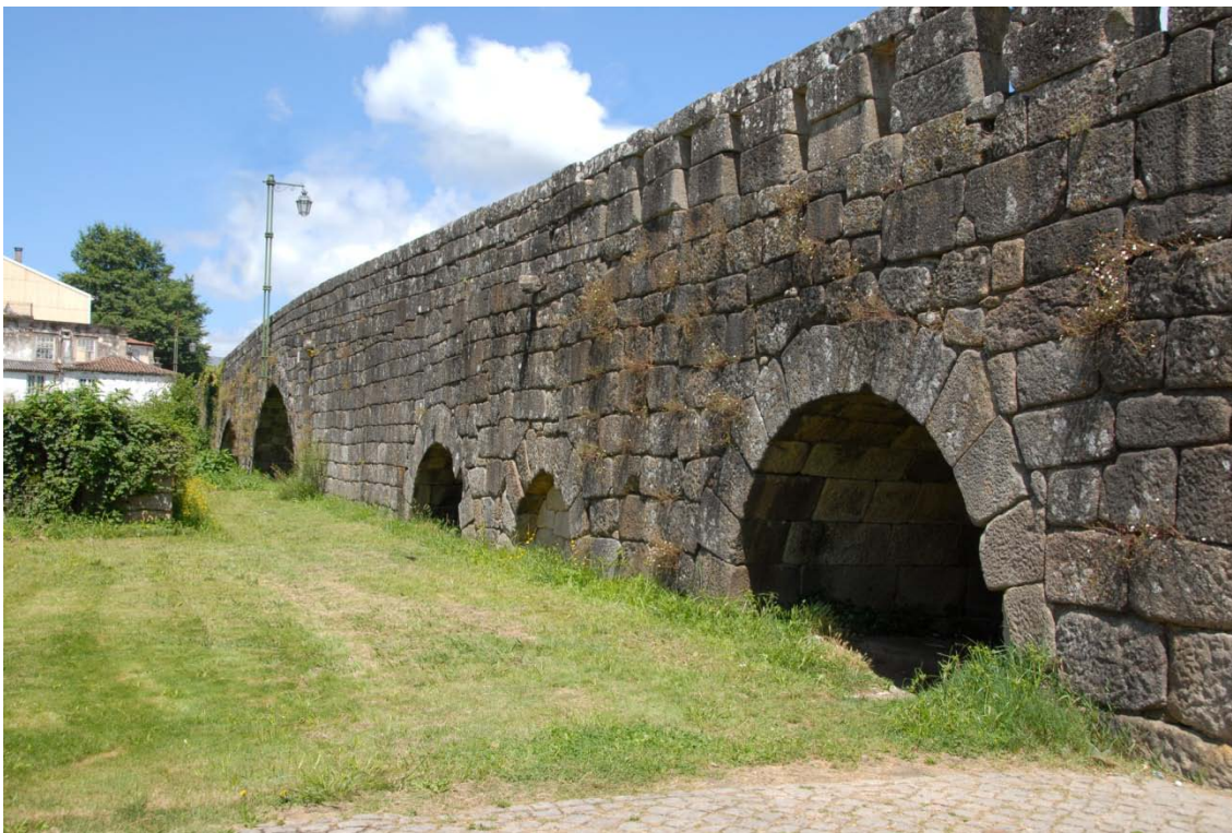
17 - O tramo romano (poente) da ponte de Ponte de Lima
