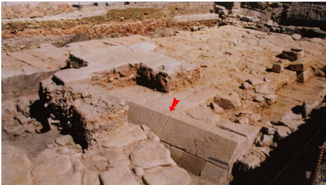
33 - A Torre da Ponte apresenta no embasamento um ligeiro alambor, que é uma característica eminentemente gótica das estruturas defensivas medievais
