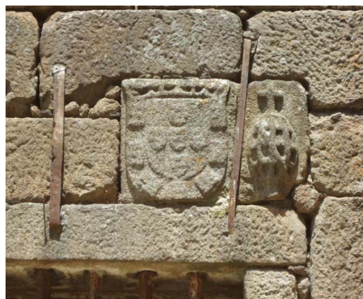
41 - Armas e empresa de D. Manuel I, cravadas junto à janela do primeiro piso
