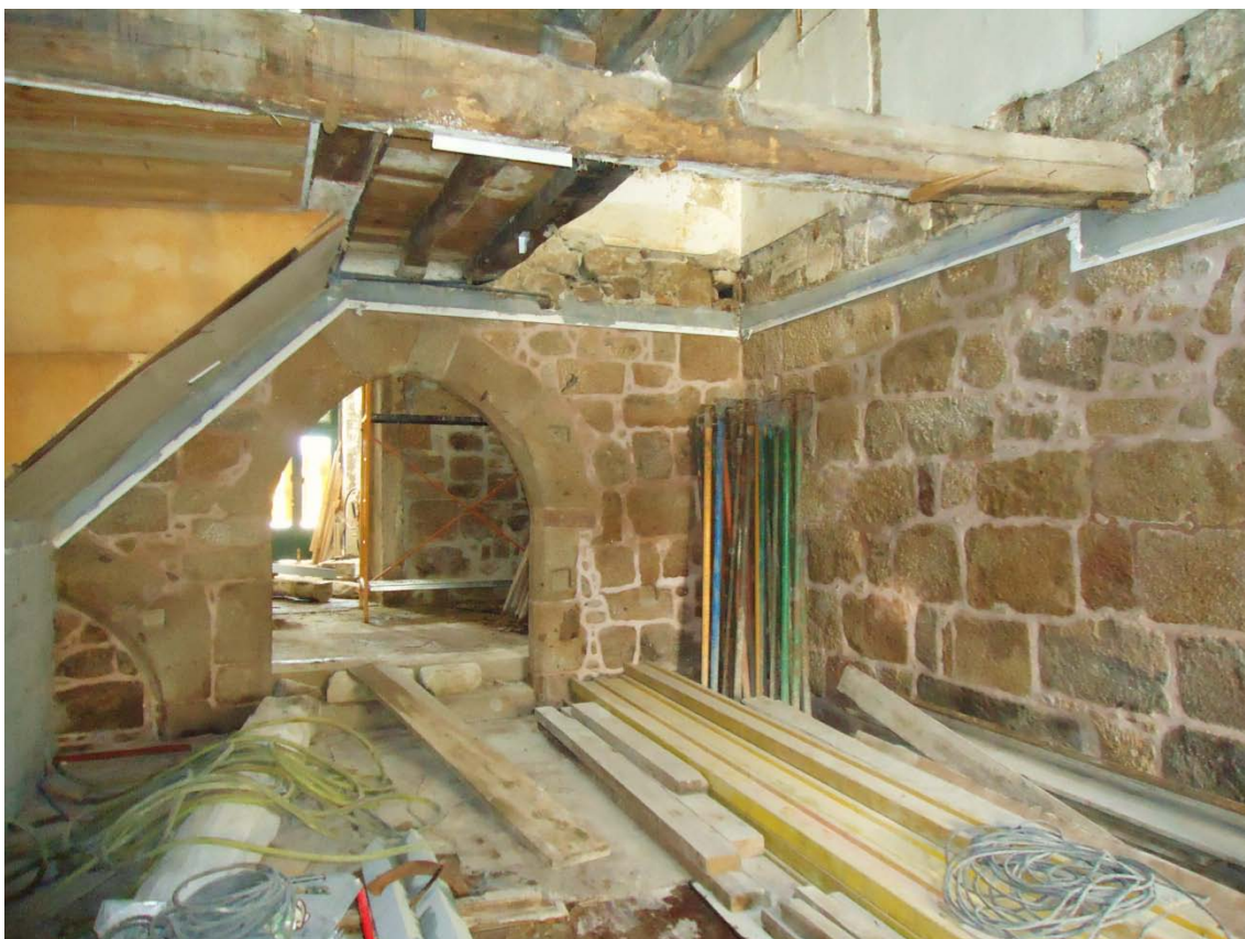
99 – As duas portas ogivais e a a silharia regular no arranque da parede norte, que refiro no texto
