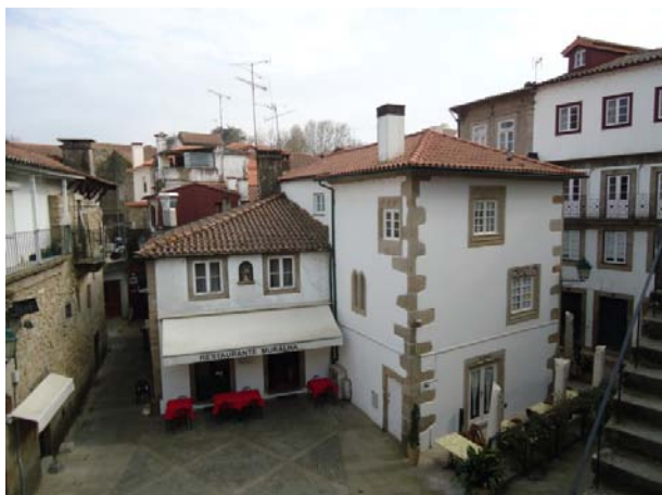
81 – É ainda perceptível, à esquerda, o espaço onde corria a azinhaga que, por trás dos enxidos, conduzia à rua do Souto
