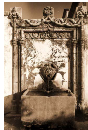
67 – Portada manuelina que integrava a fachada da Casa dos Malheiros, na rua do Souto recuada no séc. XIX.
