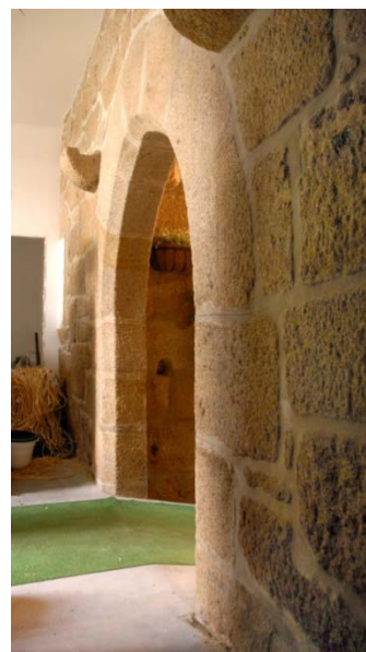
69 – Porta gótica que se abre para o vazio existente no actual quarteirão rua do Souto – rua do Castelo – rua Cardeal Saraiva
