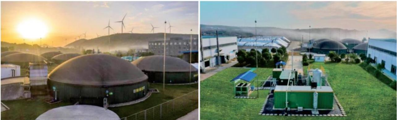
Figura 20 Instalação de biogás em Hubei Yicheng (IEA, 2024)
