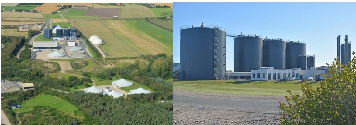
Figura 21 Unidade de biogás de Lemvig, Dinamarca.
