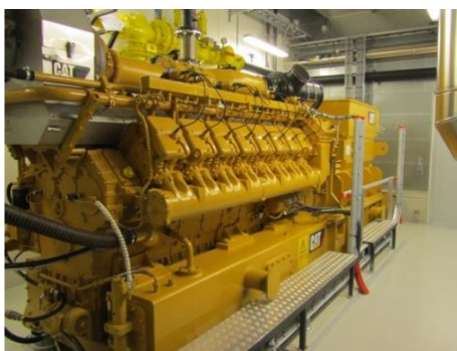
Figura 23 Motor de cogeração alimentado a biogás, CAT CG170-16 ( https://lemvigbiogas.com ).
