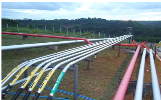
Foto 9 - Dutos / Linhas de produção e de escoamento de petróleo, gás e água e dutos/linhas de injeção de água produzida, gás ou vapor
