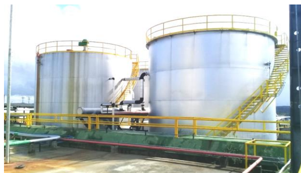
Foto 23 - Tanque pulmão de água produzida tratada
