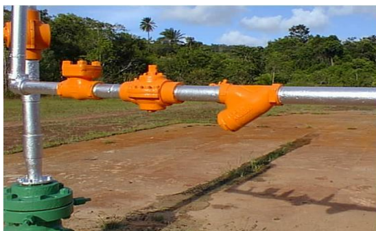
Foto 8 - Poço injetor de água produzida
