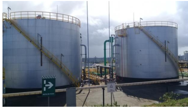
Foto 22 - Tanques de flotação de água produzida
