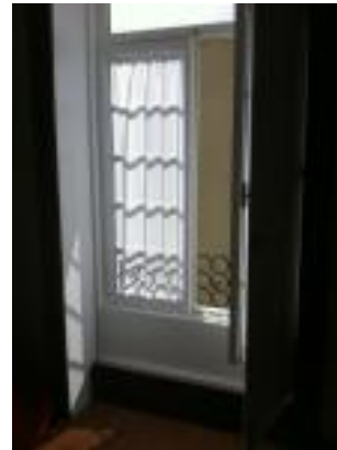
Figura 8.6 – Colocação de janelas de madeira originais, com adaptação para vidro duplo e portadas interiores
