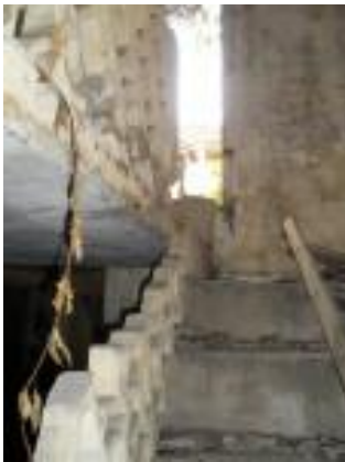
Figura 7.1 – Rebocos e betonilhas antigas para separação de resíduos
