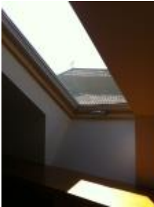
Figura 8.5 – Colocação de janelas de madeira e vidro duplo no desvão do telhado
