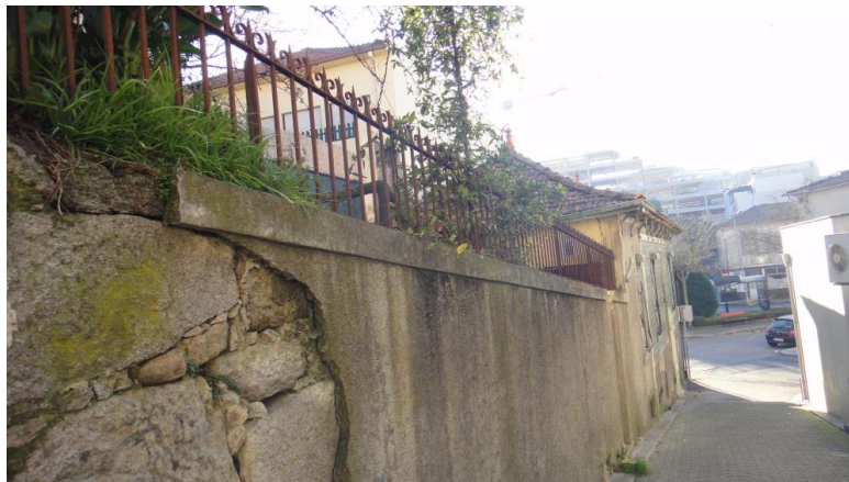
Figura 6.6 – O muro em cantaria de granito da Travessa Luz Soriano
