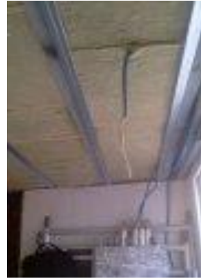
Figura 8.4 – Aplicação de lã de rocha em tetos interiores
