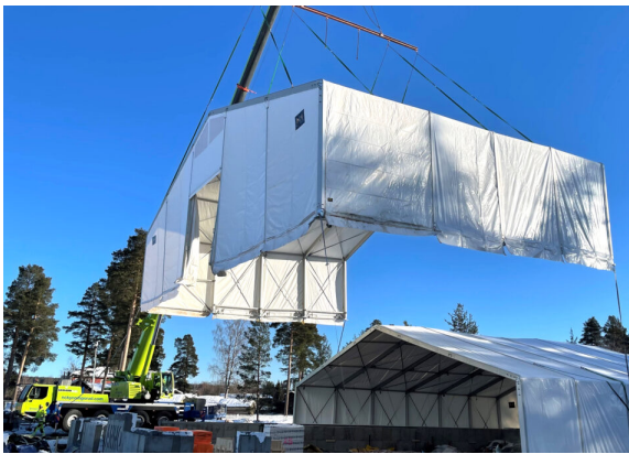
a) Uso de maquinaria pesada na montagem. Fonte - Hallgruppen
