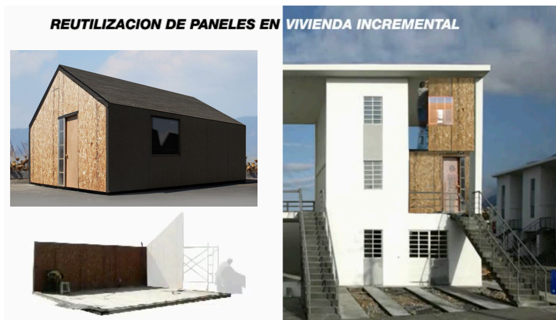
Figura 36 - Reutilização dos painéis SIP, usados na habitação temporária, na expansão das habitações permanentes Monterrey
