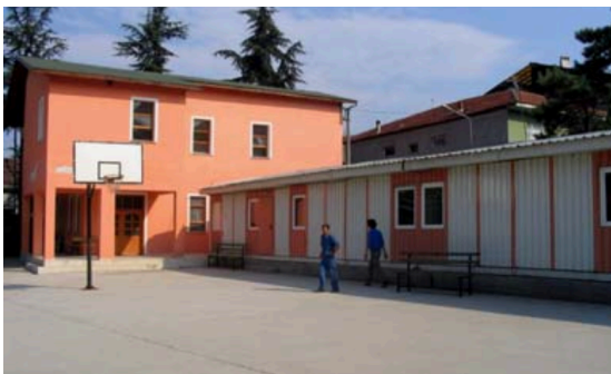
a) Edifício de oito unidades que faz parte do assentamento habitacional temporário da UMCOR Fonte - Johnson, C. (2008)
