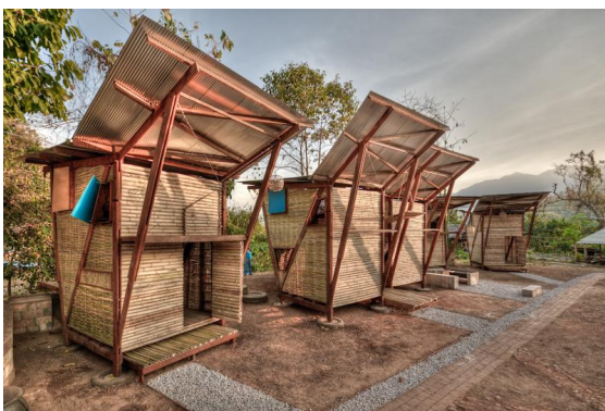
a) Habitações finalizadas. Fonte - Divisare (2009)
