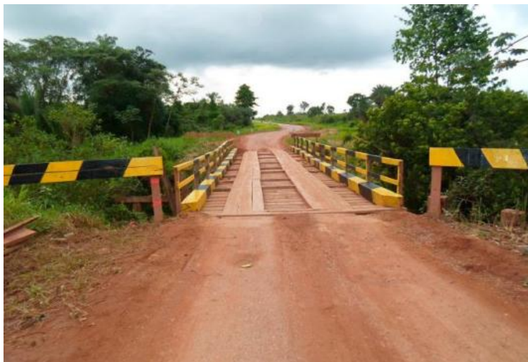
Figura 50 - Ponte 2 (provisória) recuperada, 2015 (DNIT, 2019).
