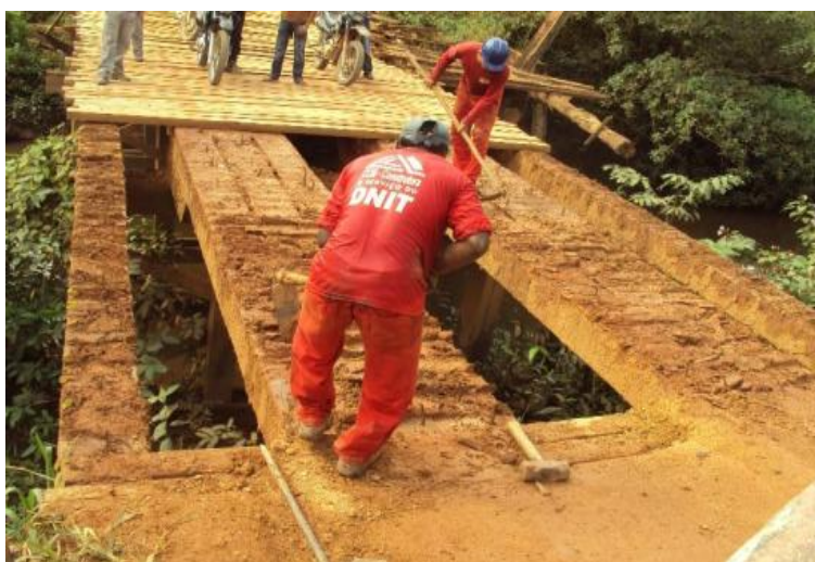
Figura 46 - Ponte 1 (provisória) em manutenção, 2013 (DNIT, 2019).
