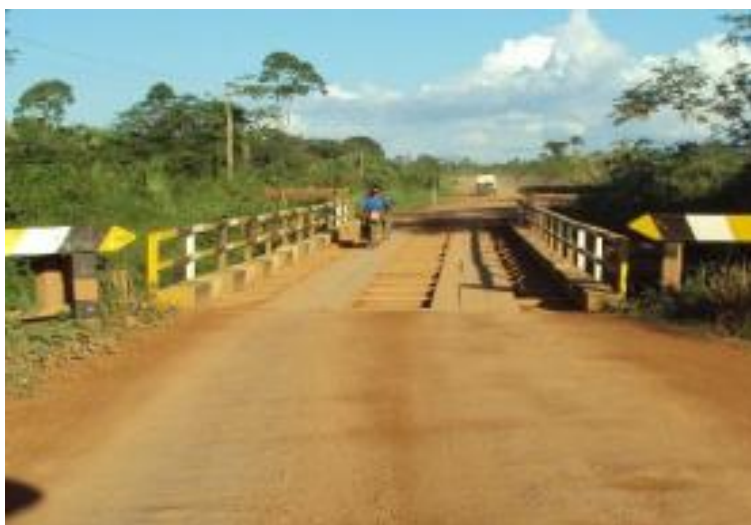
Figura 47 - Ponte 1 (provisória) recuperada, 2013 (DNIT, 2019).
