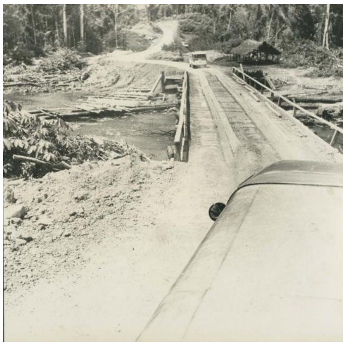
Figura 28 - Construção da BR-230 em 17 de agosto de 1971 (BRASIL/SIAN - Sistema de Informação do Arquivo Nacional, 2015).
