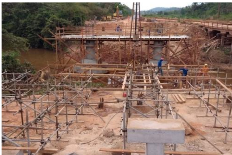
Figura 32 - Execução dos pilares da ponte definitiva (Ponte 1), com ponte provisória de madeira ainda em funcionamento.
