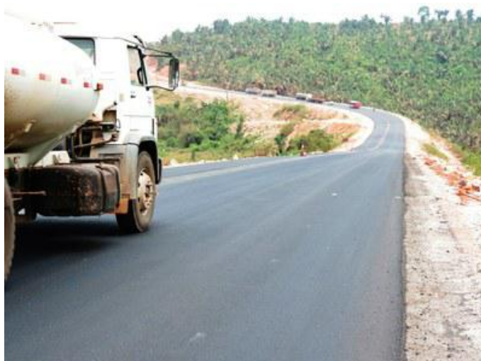
Figura 24 - Notícia: “BR-230/PA: Asfalto na Ladeira da Velha já é realidade”, Pacajá-PA, em 09 de Novembro de 2015 (BRASIL/Ministério da Infraestrutura, 2015).
