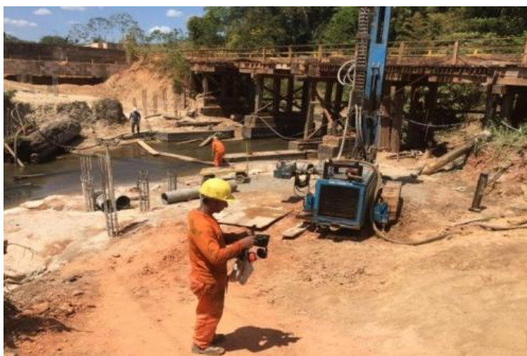
Figura 36 - Execução das estacas da ponte definitiva (Ponte 3), com ponte provisória de madeira ainda em funcionamento (DNIT, 2019).
