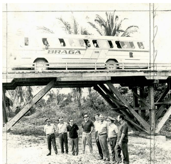
Figura 42 - Ponte provisória de madeira recém construída no ano de 1972 na BR-230 (BRASIL/SIAN - Sistema de Informação do Arquivo Nacional, 2015).
