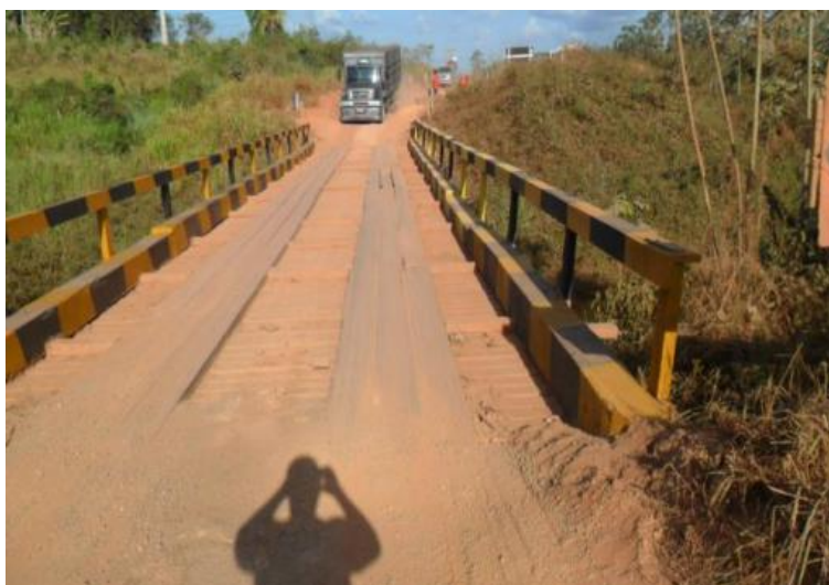
Figura 53 - Ponte 3 (provisória) recuperada, 2015 (DNIT, 2019).
