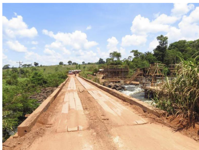
Figura 1 - Ponte sobre o Rio Cupari - Pará - BR-230 (GENTILE, 2019).
