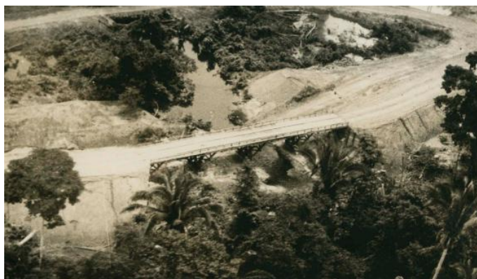
Figura 43 - Ponte provisória de madeira recém construída no ano de 1971 na BR-230 (BRASIL/SIAN - Sistema de Informação do Arquivo Nacional, 2015).
