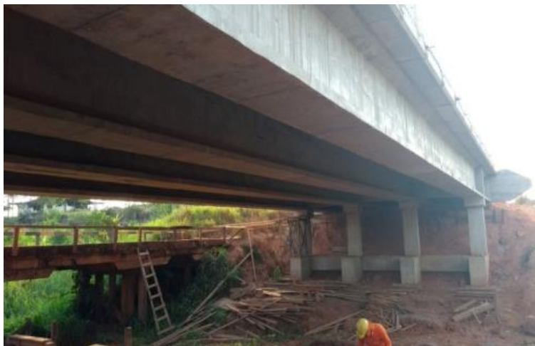
Figura 35 - Vigas longarinas concluídas da ponte definitiva (Ponte 2), com ponte provisória de madeira ainda em funcionamento (DNIT, 2019)
