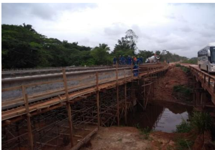
Figura 33 - Execução das vigas longarinas da ponte definitiva (Ponte 1), com ponte provisória de madeira ainda em funcionamento (DNIT, 2019).
