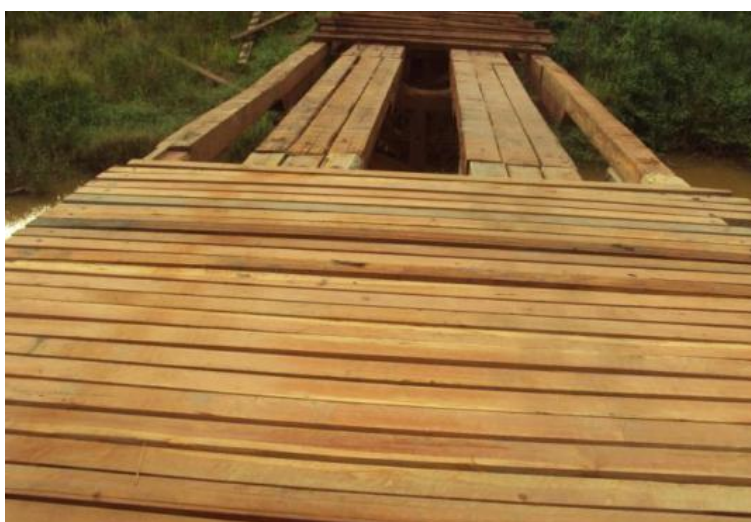
Figura 52 - Ponte 3 (provisória) em manutenção, 2015 (DNIT, 2019).
