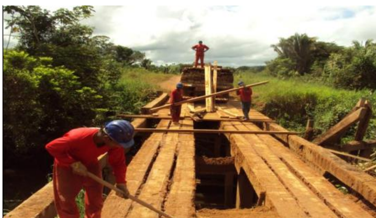
Figura 49 - Ponte 2 (provisória) em manutenção, 2015 (DNIT, 2019).
