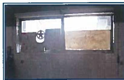
Figura IV.15. – Janelas na sala de autópsias.
