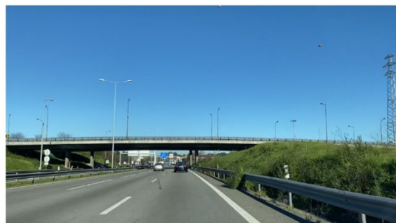
Autoestrada A28: passagem superior
