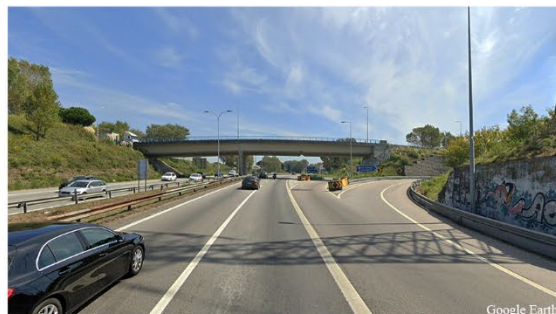
Autoestrada A28: nó 2 – sentido norte-sul
