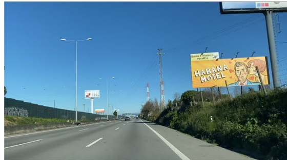
Autoestrada A28: barreira acústica
