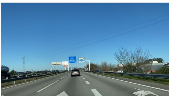
Autoestrada A28: passagem inferior
