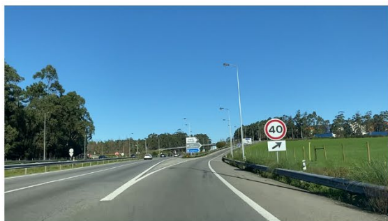
Autoestrada A28: nó 9 – sentido sul-norte
