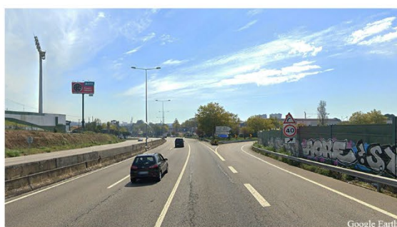
Autoestrada A28: nó 5 – sentido norte-sul
