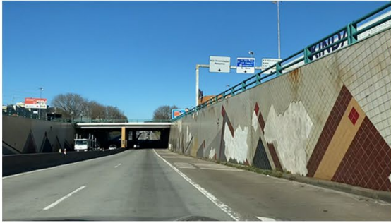
Autoestrada A28: barreira - paredes/passagem
