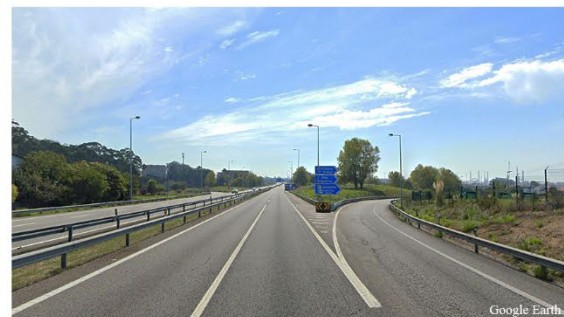
Autoestrada A28: nó 8 – sentido norte-sul
