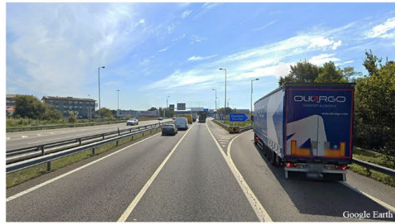
Autoestrada A28: nó 6 – sentido norte-sul
