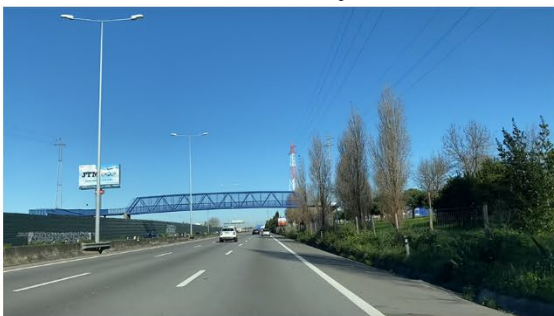
Autoestrada A28: passagem superior pedonal
