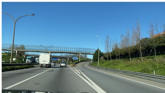
Autoestrada A28: nó 2 – sentido sul-norte
