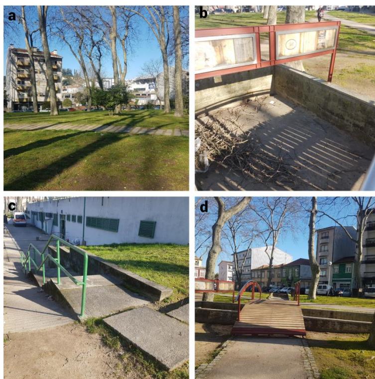
Figura 14 – Espaço verde urbano correspondente ao número 17 na Figura 7; a) vista geral do espaço; b) elemento de água desativado; c) acesso ao espaço através de escadas/rampa; d) ponte em madeira sobre elemento de água desativado
