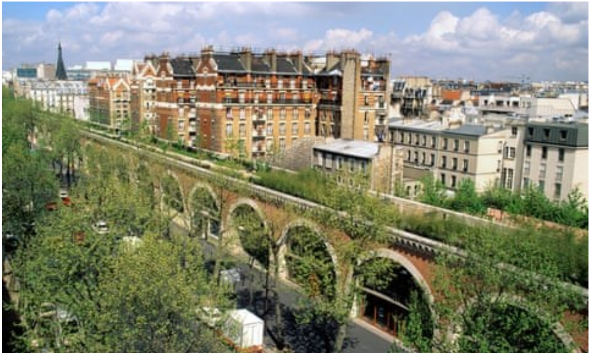
Figura 56 - Promenade Plantée – vista geral
