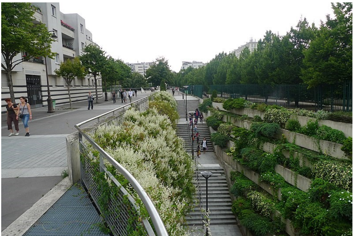
Figura 57- Promenade Plantée - acesso
