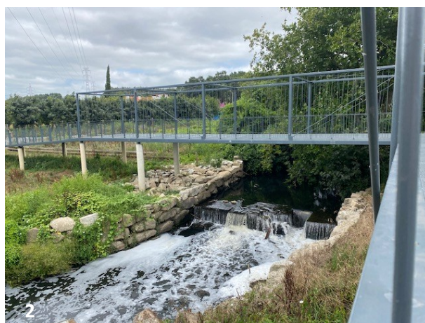
Figura 148 – Exemplo de alguns açudes e presas: 1 – Açude; 2 – Presa
