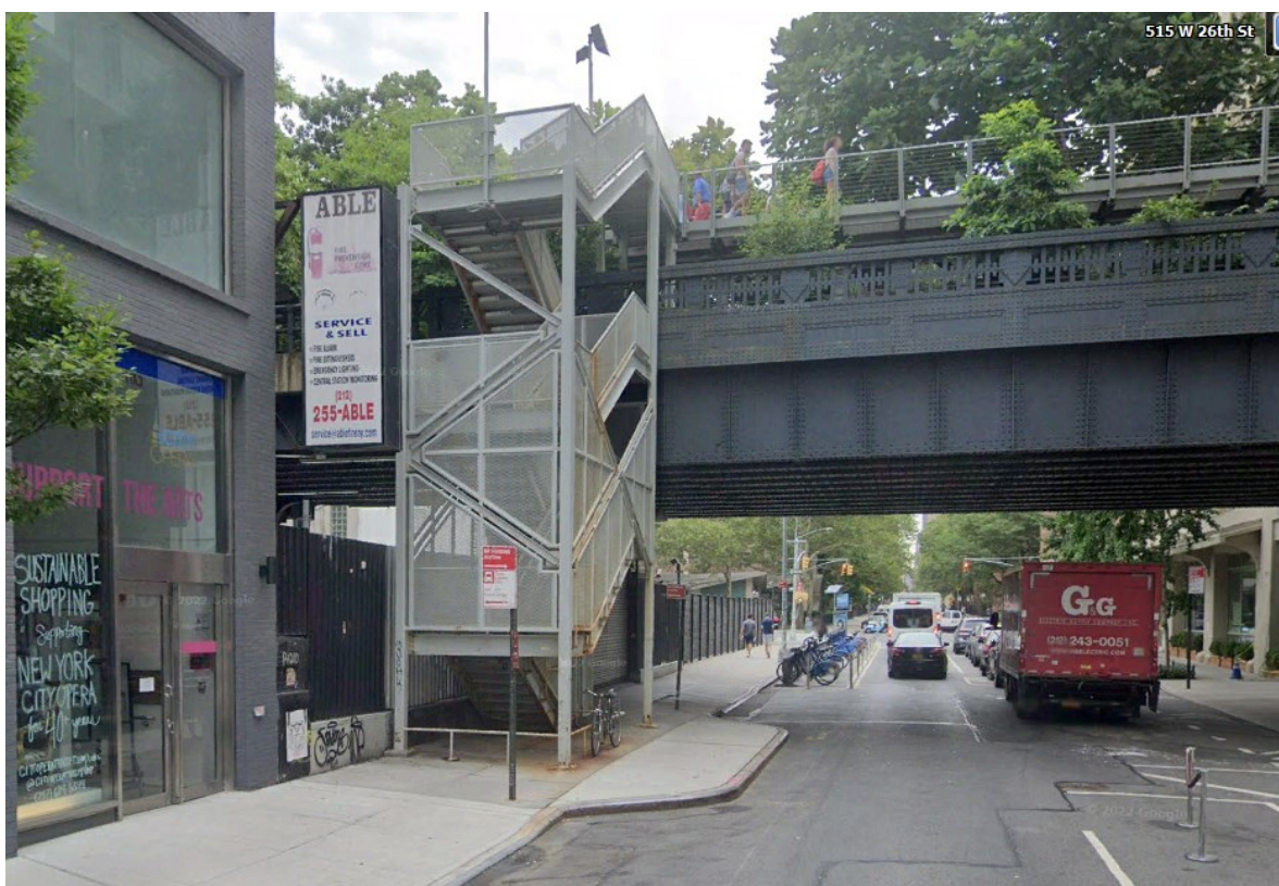
Figura 69 – Acesso em escada para a High Line
