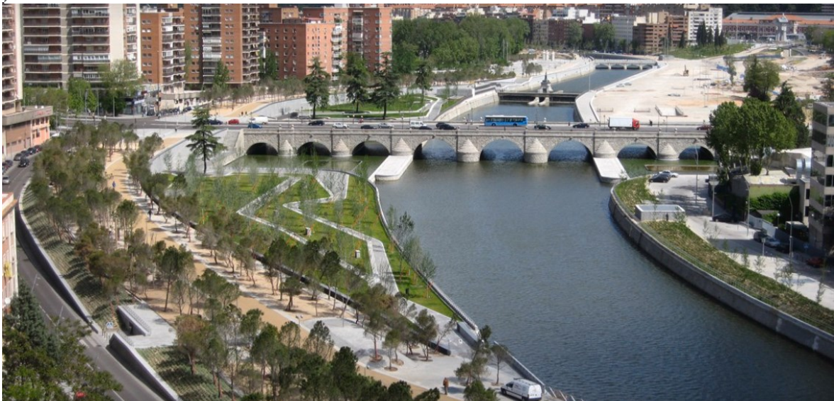
Figura 42 - Plataforma da Ponte de Segóvia
