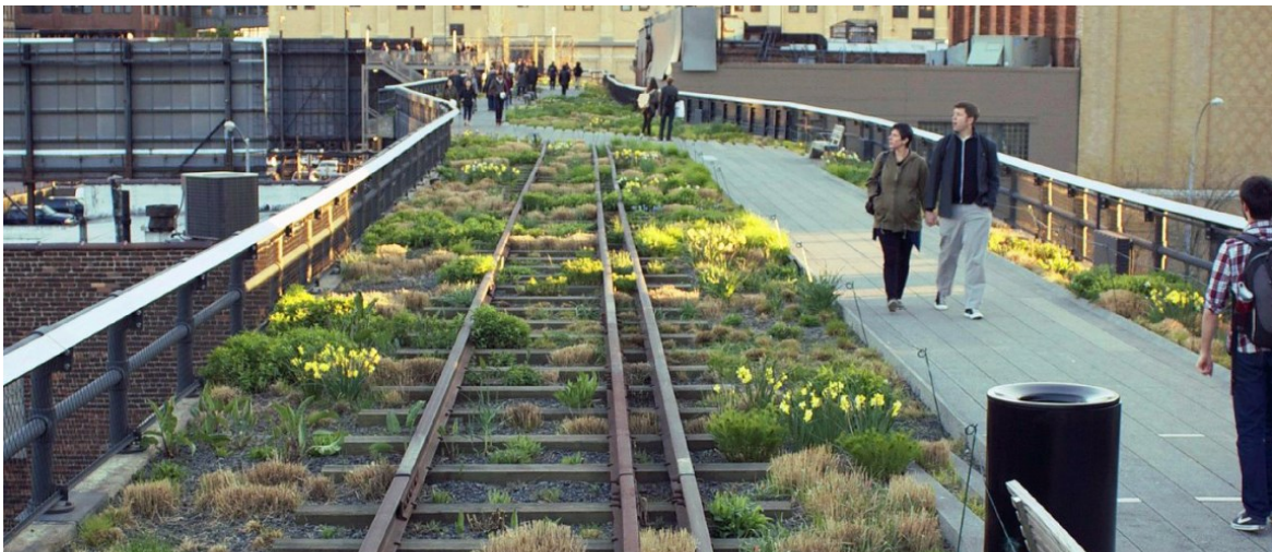
Figura 74 - Área verde plantada deixando visível os carris da antiga linha
