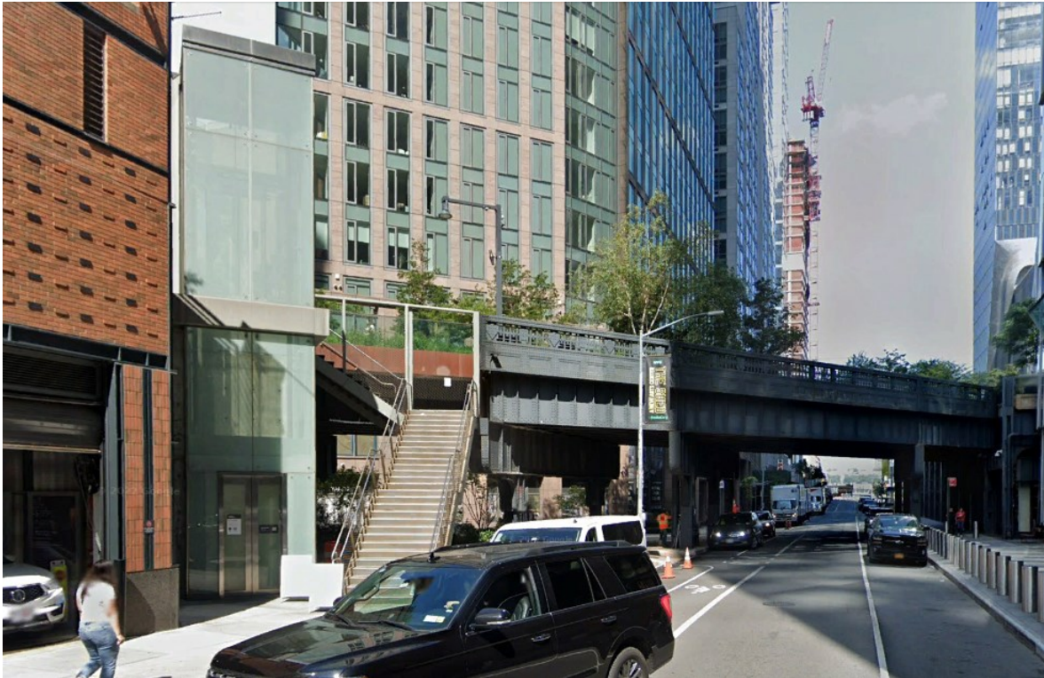
Figura 68 - Acesso em escada e elevador para a High Line
