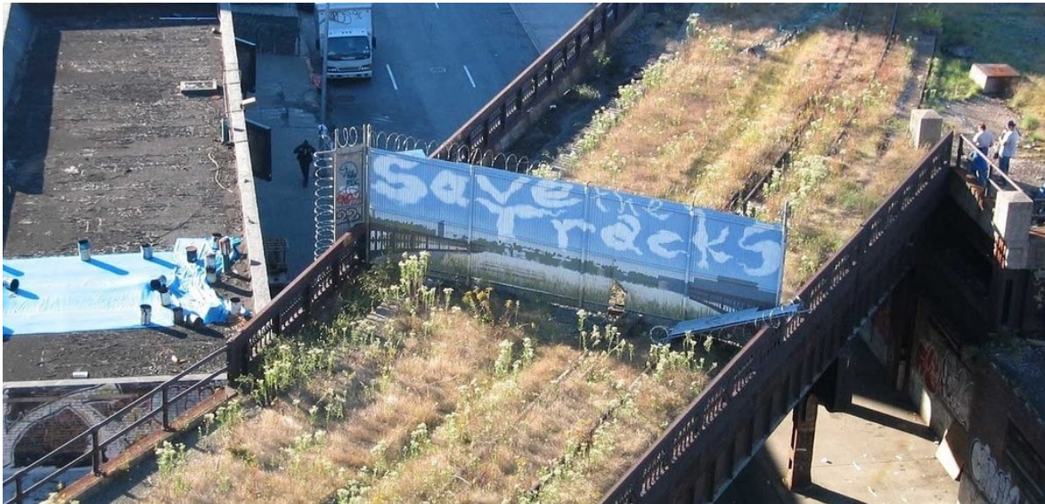
Figura 73 - Aspeto da linha abandonada
