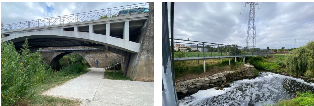
Figura 147 - Exemplo de pontes pré-existente e de travessia construída fonte: da autora
