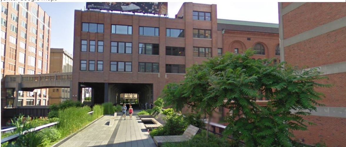
Figura 64 – Edifícios atravessados pela High Line
