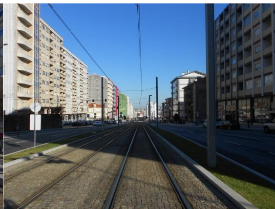
Figura 73 | Vista espaço-canal sentido norte, (2015) Fonte: Autor
