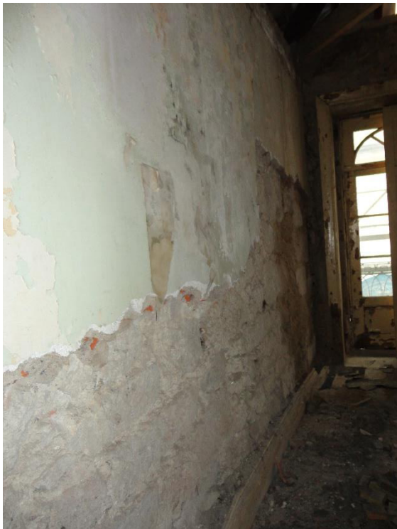
Figura 7 – Demolição de rebocos.
