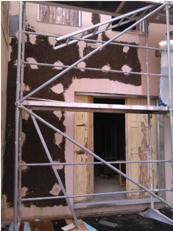
Figura 1 – Revestimento de fachada.
