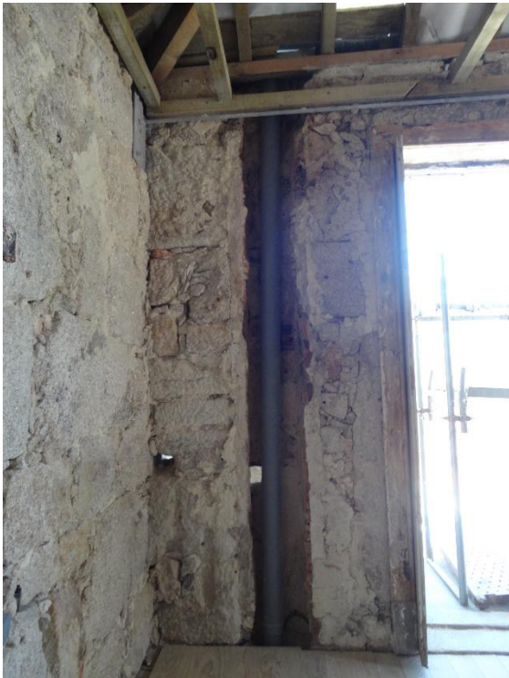
Figura 7 – Abertura de courette na parede.
