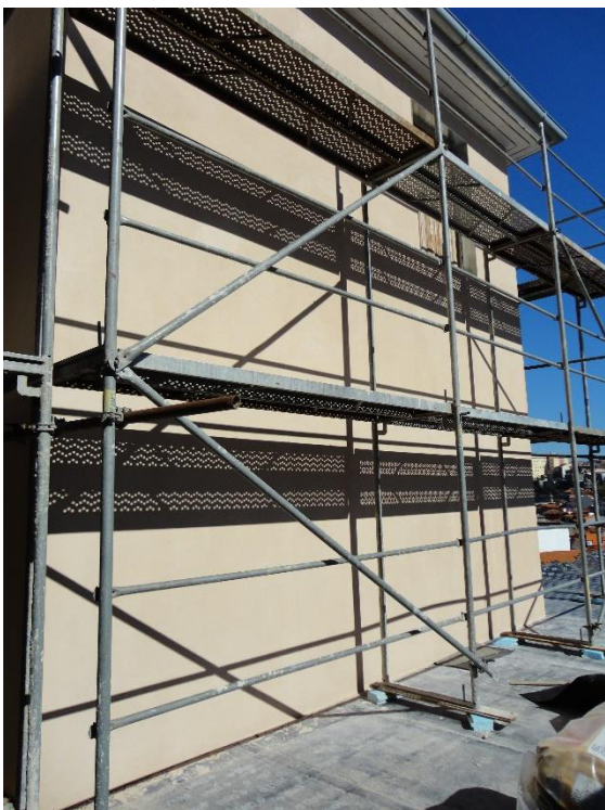
Figura 7 – Paredes com acabamento final.
