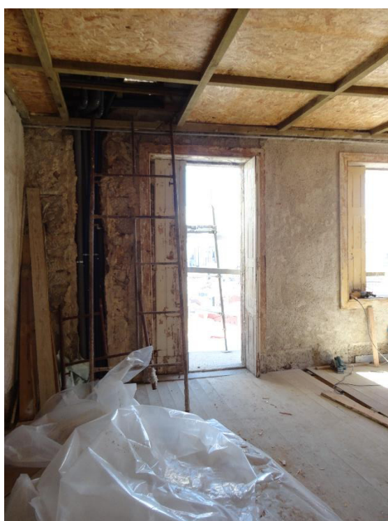
Figura 4 – Tetos fechados a placas de OSB.
