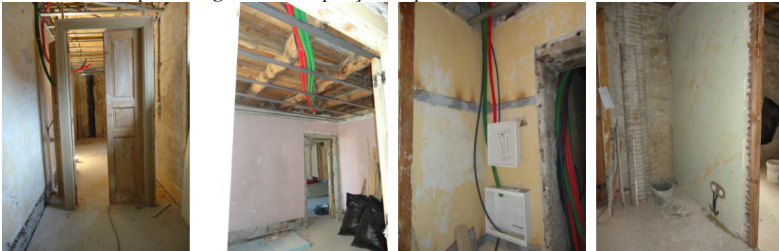
Figura 109 – Novas portas interiores Figura 110 – Tubos de eletricidade no teto falso Figura 111 – Instalação de quadros elétricos Figura 112 – Abertura de fichas elétricas nas paredes interiores.
