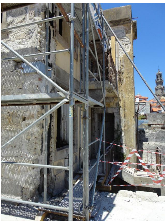
Figura 3 – Obras fachada alçado tardoz.
