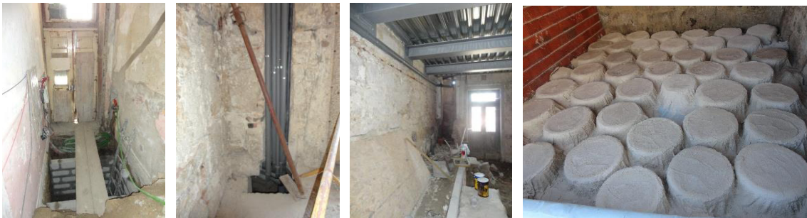
Figura 95 – Caixas de saneamento na entrada Figura 96 - Passagem de tubos Figura 97 – Passagens de tubos suspensos Figura 98 – Camada de betão pobre
