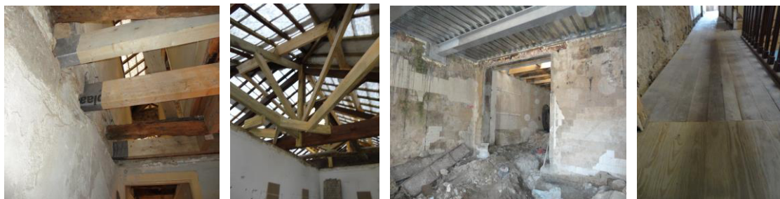
Figura 66 - Vigas novas Figura 67 – cobertura Figura 68 - Pavimentos demolidos Figura 69 – Encontro do soalho novo com o velho.
