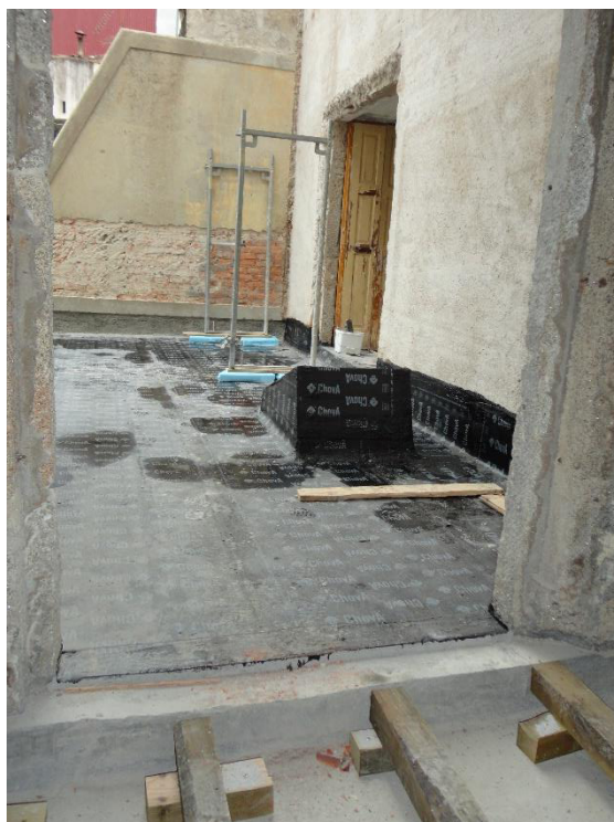
Figura 2 – Tela asfáltica na cobertura plana.
