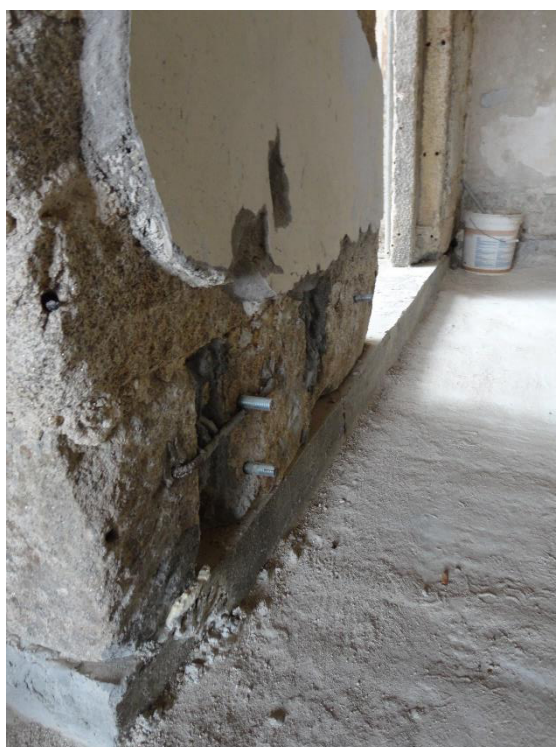
Figura 4 – Sustentação de fachadas.
