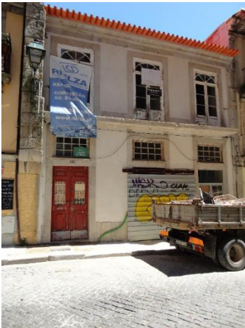
Figura 34 - Fachada principal do edifício com exemplo da parede de meação com o edifício vizinho à esquerda da porta de entrada.
