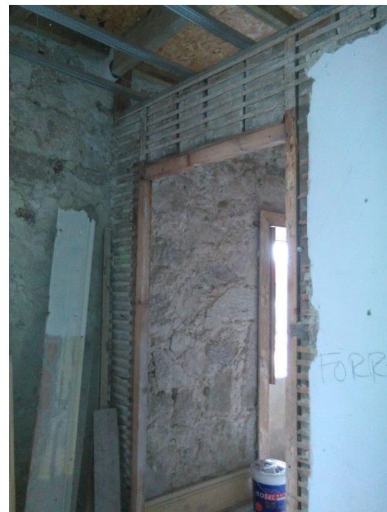
Figura 4 – Paredes de tabique a serem reconstruídas.
