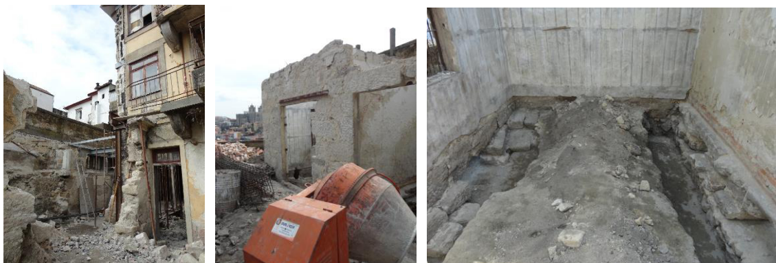
Figura 79 – Cobertura demolida Figura 80 – Paredes escoradas Figura 81 – Valas para tubagens.
