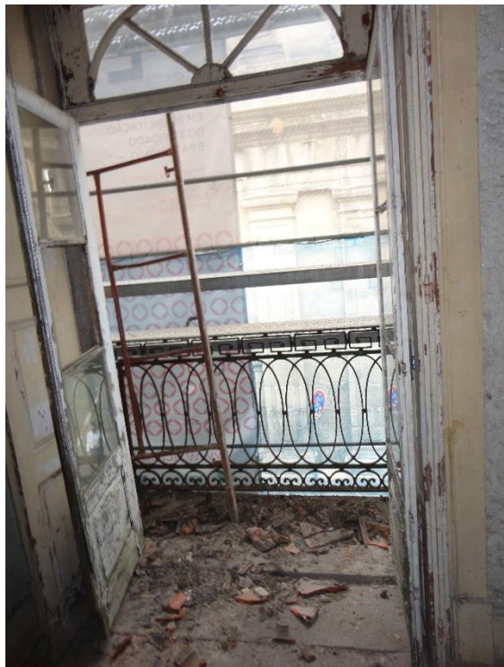
Figura 8 – Porta de varanda (obras na fachada).
