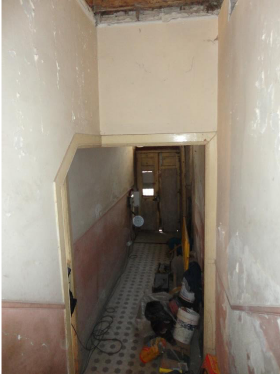
Figura 5 – Piso de entrada.
