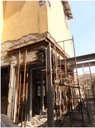
Figura 47 - Reforço de paredes através de vigas metálicas
