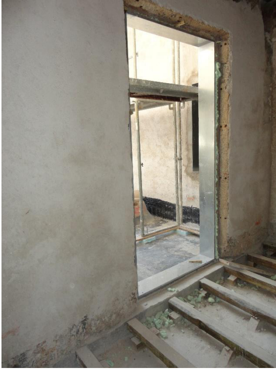
Figura 5 – Aro metálico nas aberturas.
