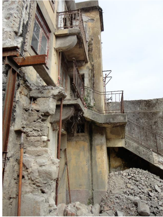
Figura 6 – Paredes corpo 3 demolidas.
