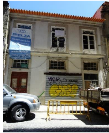
Figura 61 - Exemplo dos lancis de pedra em torno de todas as aberturas na fachada principal.
