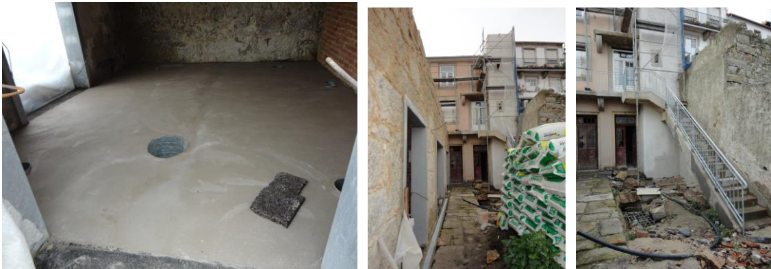
Figura 113 – Pavimento pronto para acabamento final Figura 114 – Alçado pintado Figura 115 – Guarda de ferro nova.
