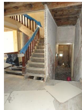
Figura 39 - Parede interior de escada de tabique simples.
