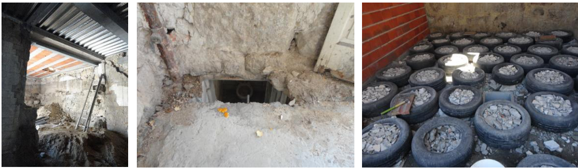
Figura 89 – Lajes novas. Figura 90 - Courette rasgada Figura 91 - Pneus com enchimento a cascalho
