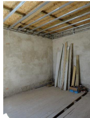
Figura 51 - Revestimento do teto a celenit.
