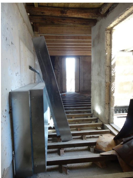
Figura 3 – Nova estrutura para assentar soalho.
