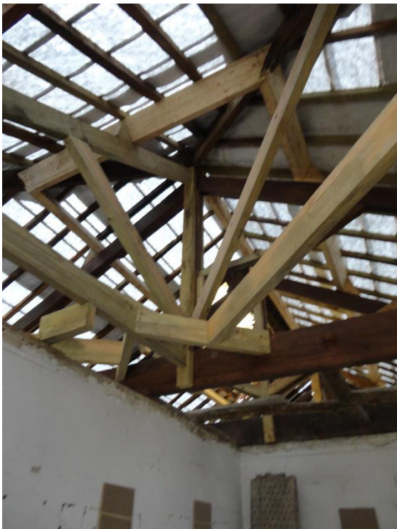
Figura 7 – Elementos da cobertura novos.
