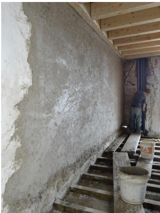
Figura 1 – Paredes rebocadas de novo.
