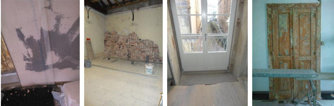
Figura 105 – Acabamento das paredes Figura 106 – Módulo sanitário piso 1 a ser marcado Figura 107 – Caixilharia nova aplicada Figura 108 – Reparação das portas interiores.
