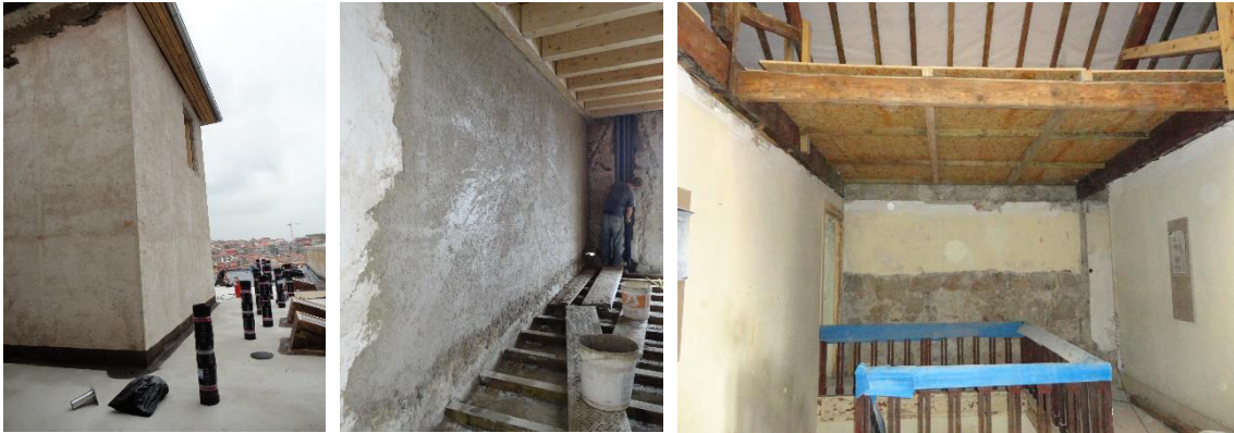
Figura 99 – Cobertura plana com tela asfáltica a ser aplicada. Figura 100 – Paredes corpo 2 rebocadas. Figura 101 – Aplicação de placas de OSB no teto do piso 1.
