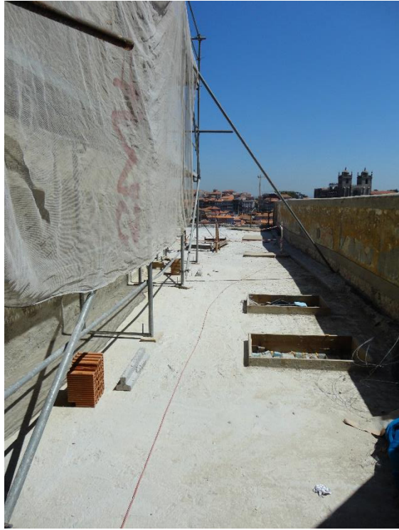
Figura 6 – Nova cobertura plana.
