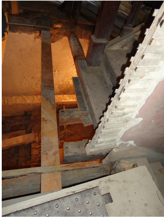
Figura 6 – Demolição pavimento junto da escada.
