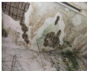
Figura 11 - Cofragem por dentro
