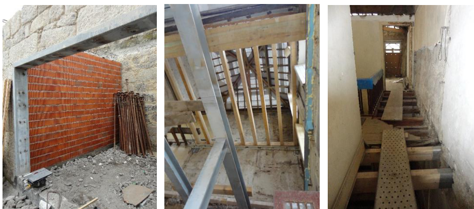
Figura 86 – Paredes de tijolo novas. Figura 87 – Estrutura de sobrado novo Figura 88 – Salho retirado.
