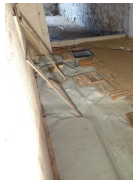
Figura 45 - Telhas a fazer a caixa-de-ar e terra a cobrir.
