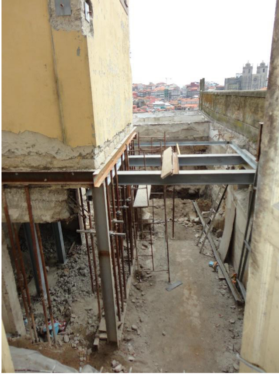
Figura 5 – Cobertura plana demolida.
