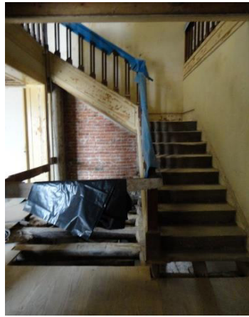
Figura 60 - Escada de 2 lanços.
