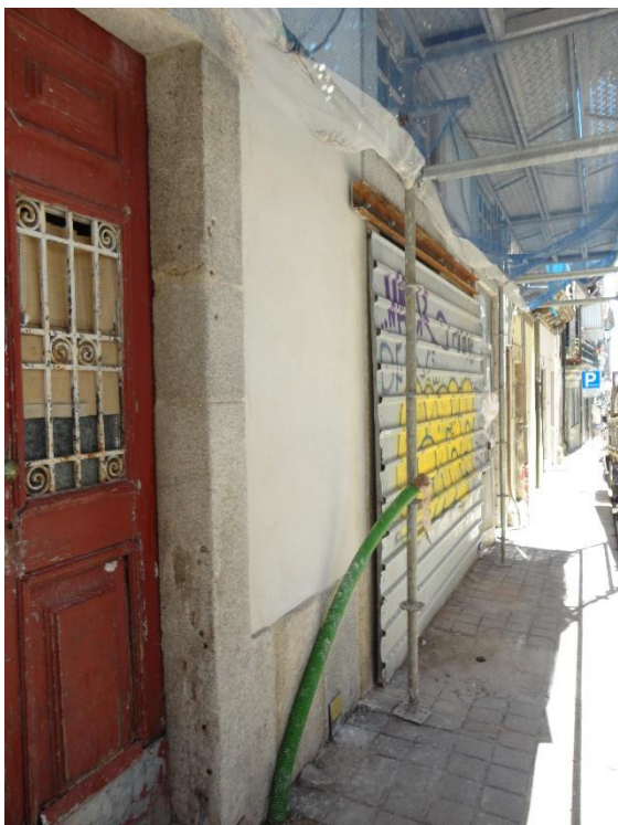
Figura 1 – Parede alçado frontal rebocado.
