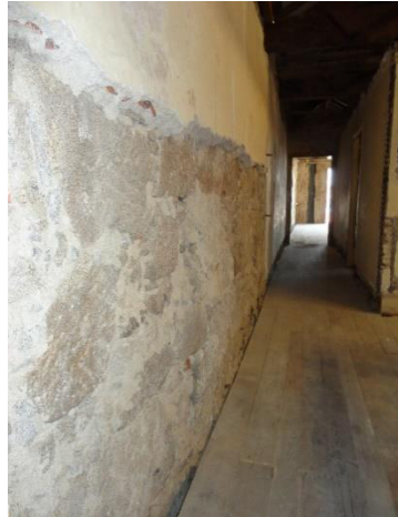
Figura 35 - A mesma parede de meação vista de dentro, com revestimento retirado até à alvenaria de pedra.
