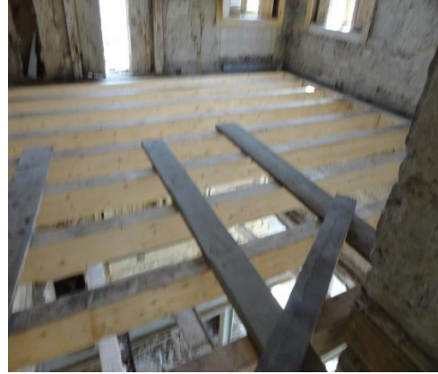
Figura 49 - Corpo do edifício no alçado posterior com o vigamento todo substituído.
