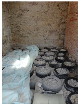
Figura 44 - Manta geotêxtil a cobrir os pneus.
