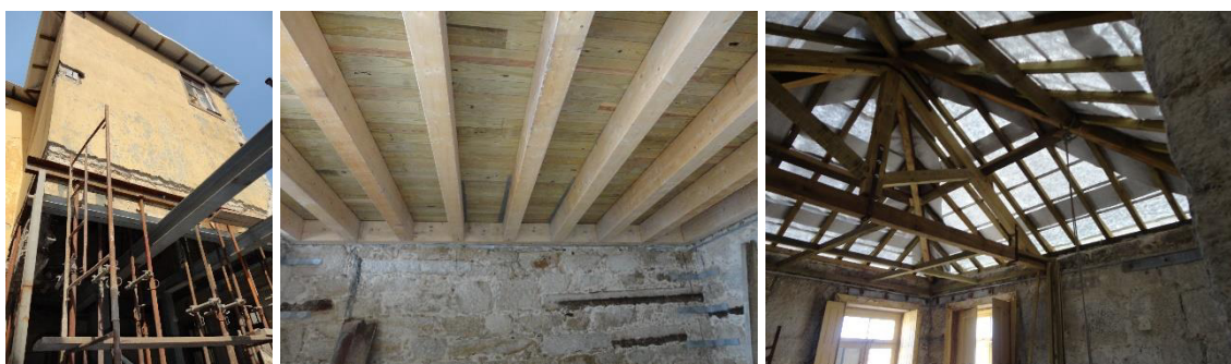
Figura 74 - Tirantes pelo exterior. Figura 75 - Estrutura sobrado novo. Figura 76 - Estrutura cobertura nova.
