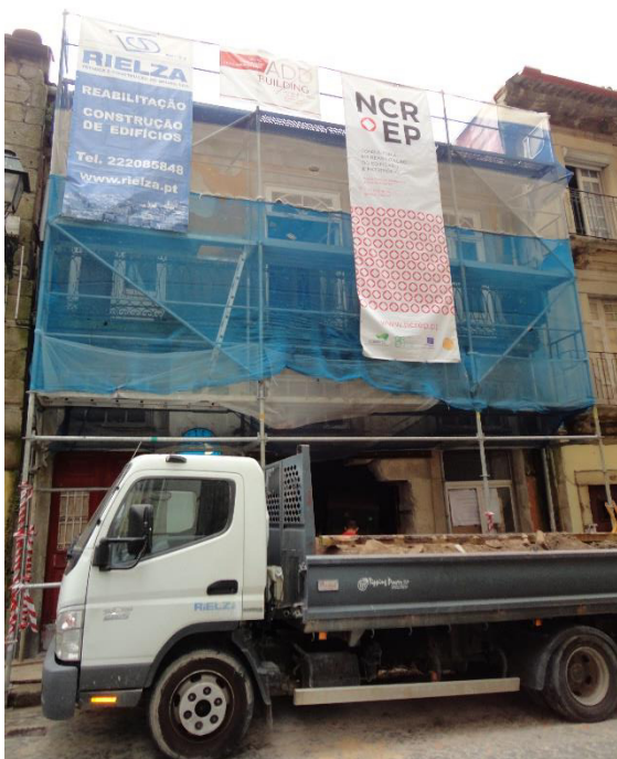
Figura 1 – Obras no alçado frontal.
