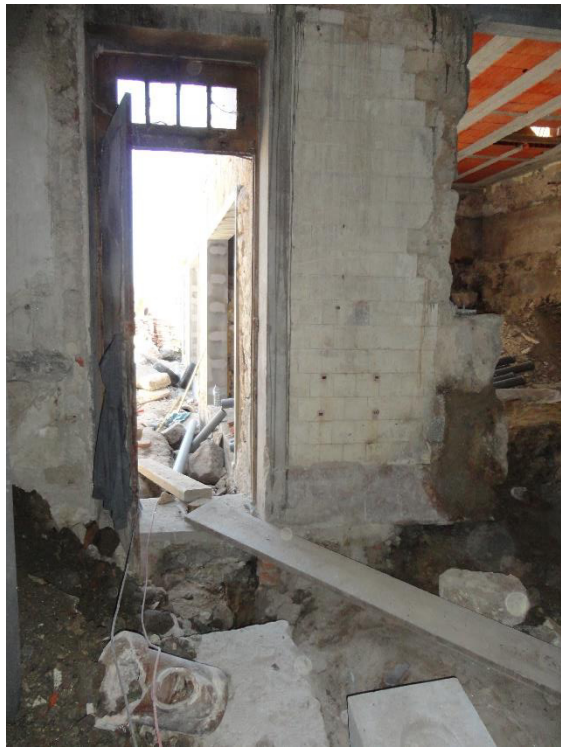
Figura 6 – Pavimentos piso -1 demolidos.
