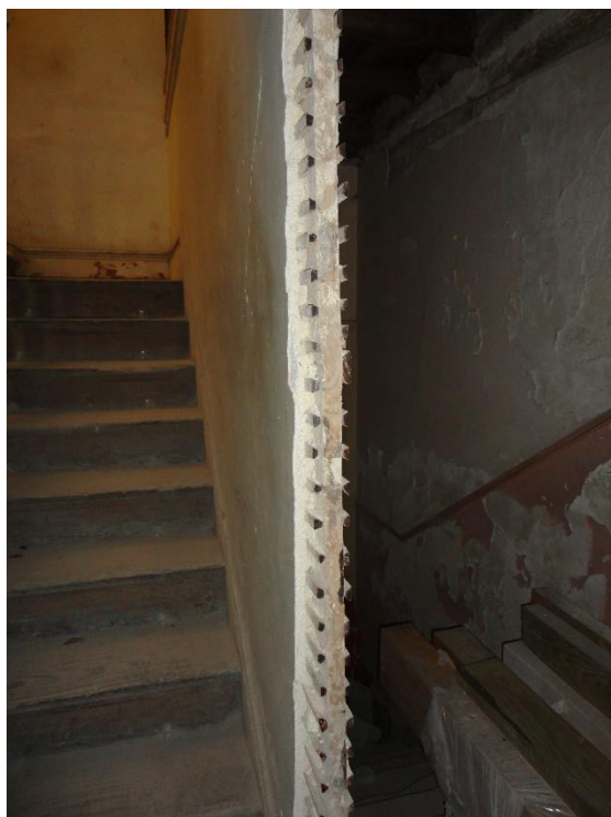
Figura 2 – Parede interior de tabique.
