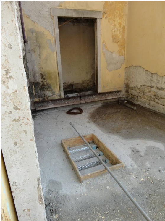
Figura 5 – Claraboia aberta na nova laje.
