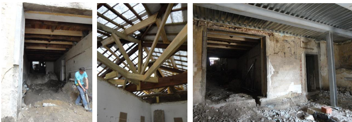
Figura 24 - Vigas substituídas. Figura 25 - Elementos cobertura substituídos. Figura 26 – Laje metálica.
