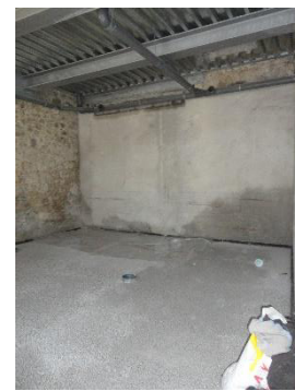
Figura 46 - Pneus enchidos a betonilha pronto a ser aplicado o pavimento final.
