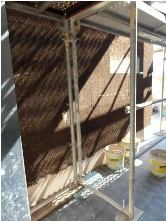
Figura 6 – Revestimento da fachada a cortiça.
