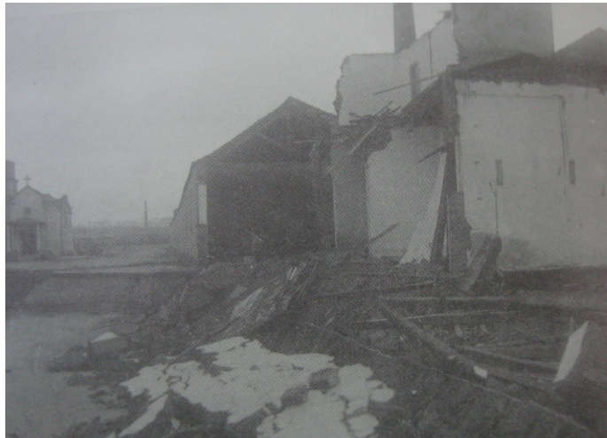
Figura 16 – Destruição da fábrica Brandão, Gomes & Cª, pela ação do Mar
