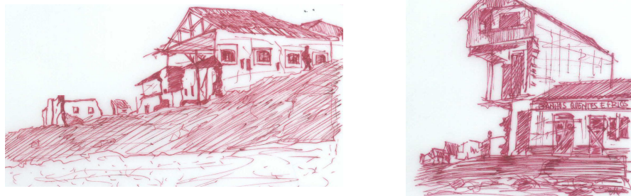
Figura 13 - Prédios destruídos pela invasão do Mar
