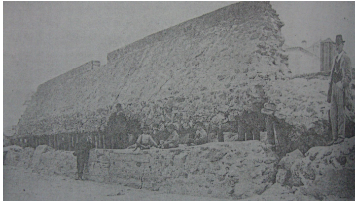
Figura 17 – Muralha de defesa, construída em 1909.
