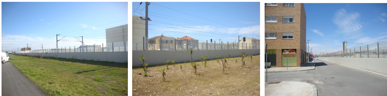
Figura 33 - Muros da linha férrea como barreira, fraturando a cidade
