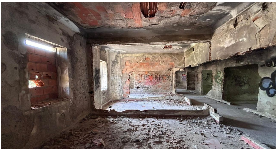
Figura 76 - Paredes interiores destruídos (marcas de treino dos bombeiros)
