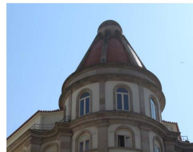
Figura 36 – Pormenores da Fiação Fonte: Ferreira, 2017
