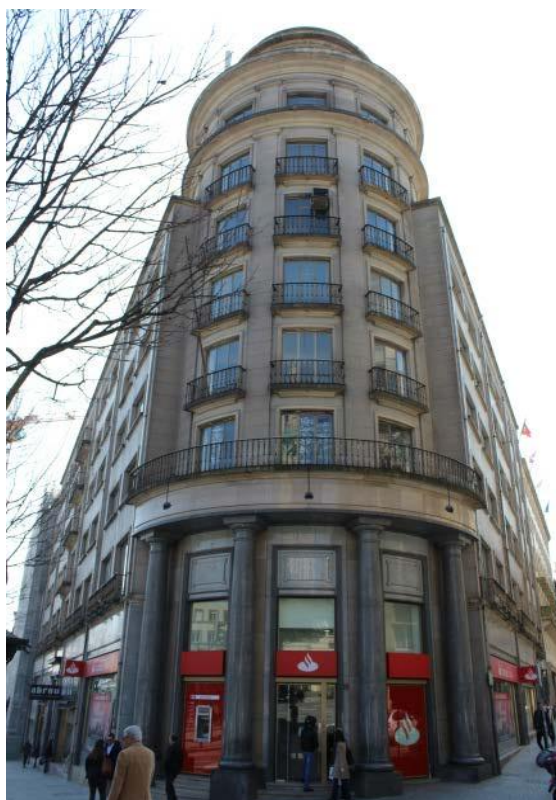
Figura 40 – Aspeto frontal do edifício Fonte: Ferreira, 2017
