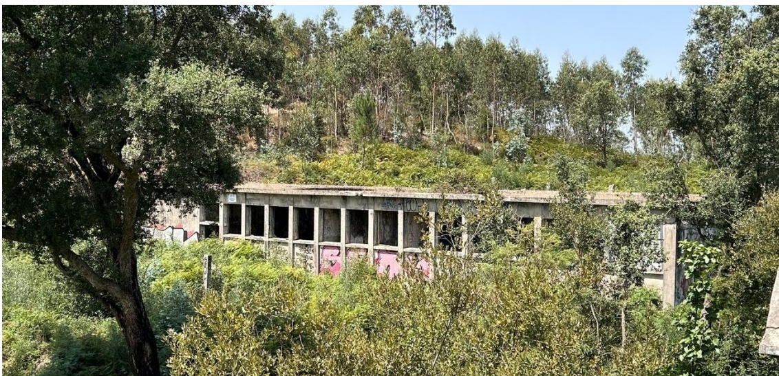
Figura 71 – Edifício da lavanderia Fonte: Autor, 2025
