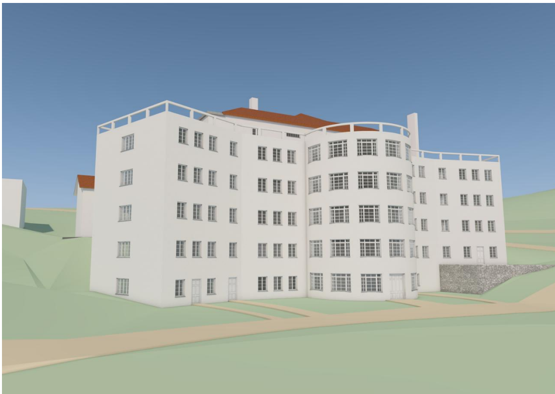
Figura 85 – Vista Sudeste para o modelo do sanatório (note-se a lisura das fachadas e o efeito do recuo da cobertura) Fonte: Reconstrução do autor, 2025
