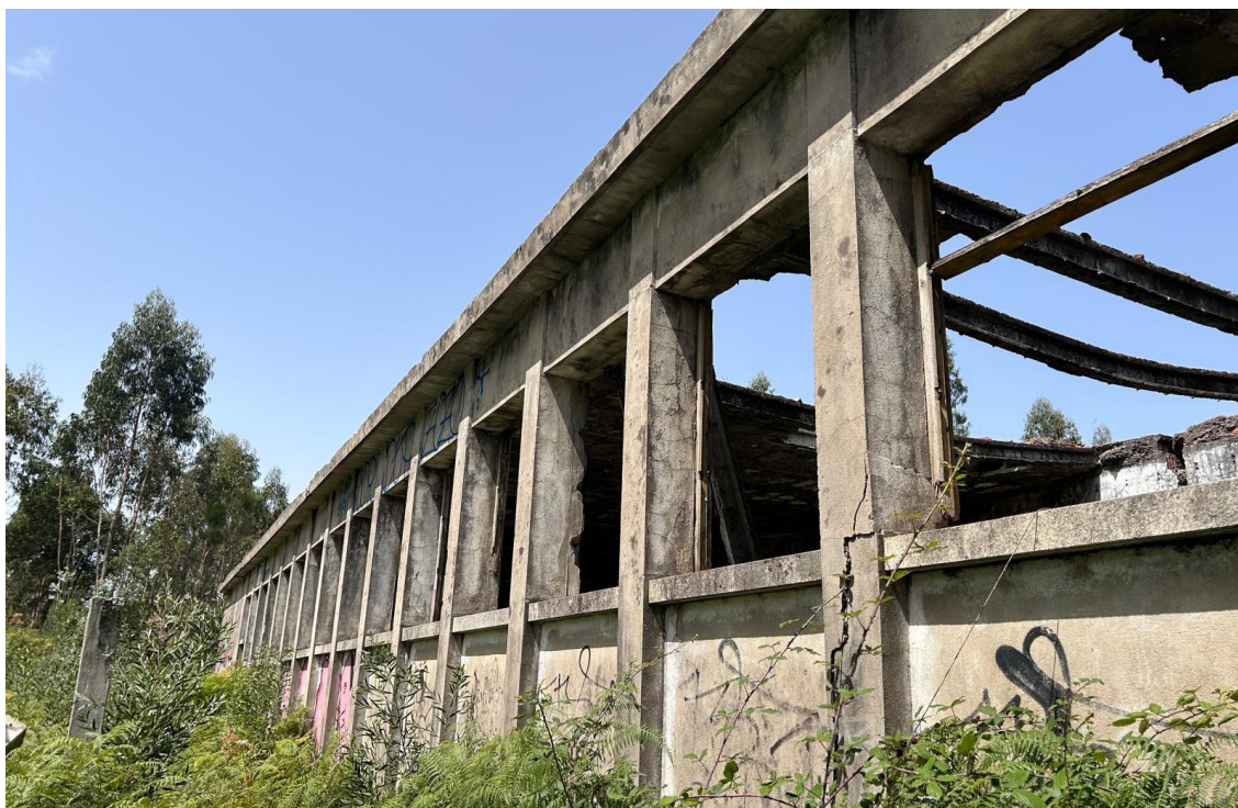
Figura 93 – Fachada da lavanderia (note-se a modularidade e efeito “grelha” dos vãos) Fonte: Autor, 2025
