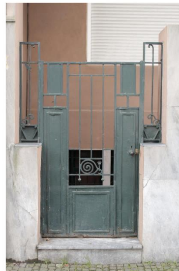
Figura 16 – Detalhe do portão da casa Fonte: Ferreira. 2017
