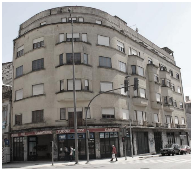
Figura 25- Edifício na rua do Duque de Loulé Fonte: Ferreira, 2017
