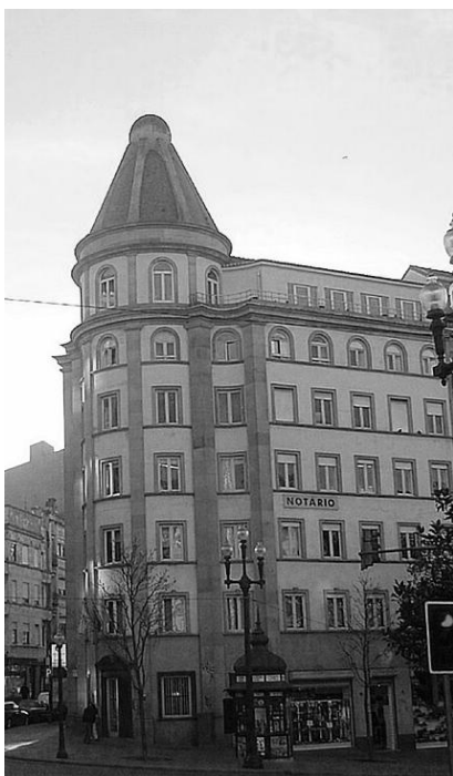
Figura 34 – Edifício da Companhia de Fiação e Tecidos de Fafe (1943-1944) Fonte: flickr
