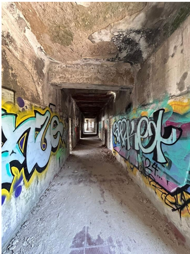
Figura 82 – Aspeto atual do corredor entre as alas laterais Fonte: Autor, 2025
