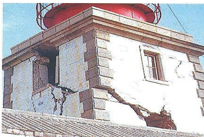
Figura 11 – Consequência de sismo nos Açores, em construção de alvenaria
