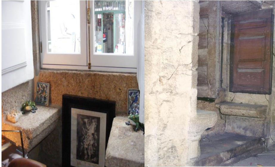
Figura 60 – “ Namoradeiras” em pedra na janela da fachada principal (antes e depois)
