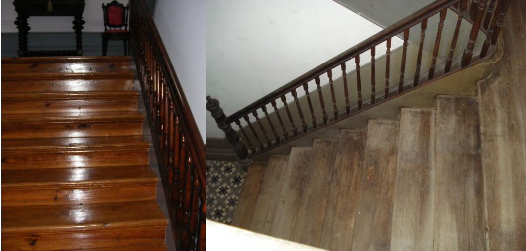
Figura 54 – Restauro da escadaria principal (antes e depois)
