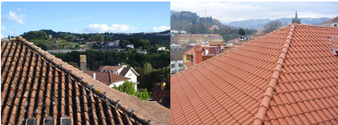
Figura 2 – Processo de substituição de telhado (antes e depois)
