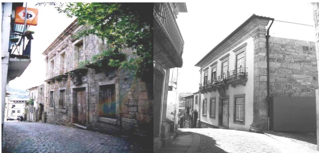
Figura 31 – Fachada principal (antes e depois)
