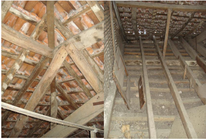
Figura 64 – Estrutura de madeira pertencente à cobertura
