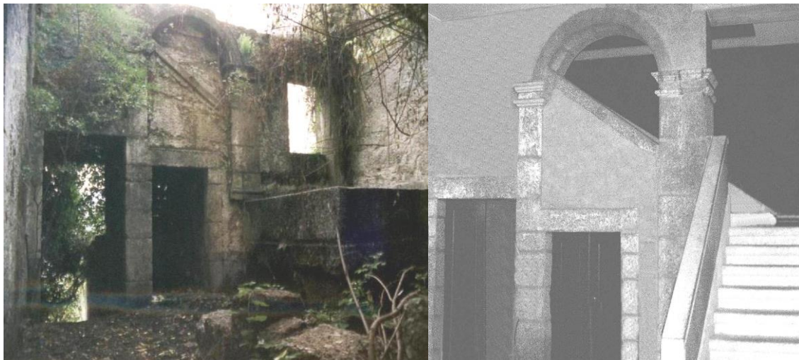
Figura 32 – Arco da escadaria principal no rés-do-chão (antes e depois)
