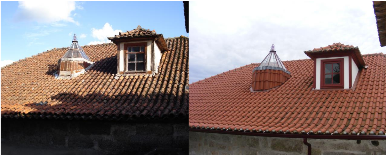
Figura 63 – Vista da clarabóia, vão de cobertura e telhado (antes e depois)
