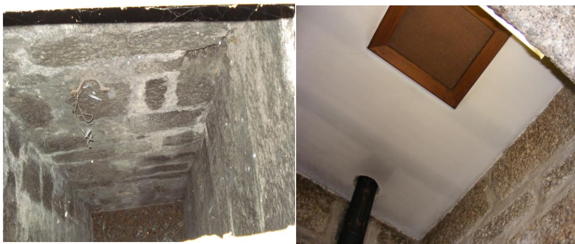
Figura 59 – Cone da chaminé na cozinha (antes e depois)
