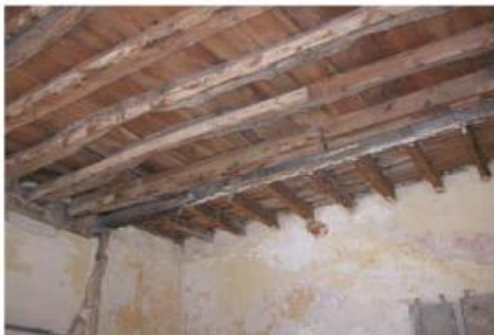
Figura 8 – Vigas e soalho
