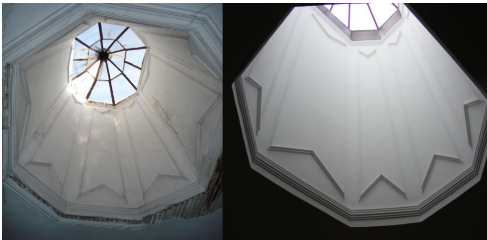
Figura 65 – Interior da clarabóia (antes e depois)
