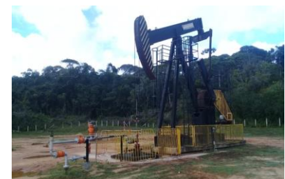
Poço Produtor de óleo
