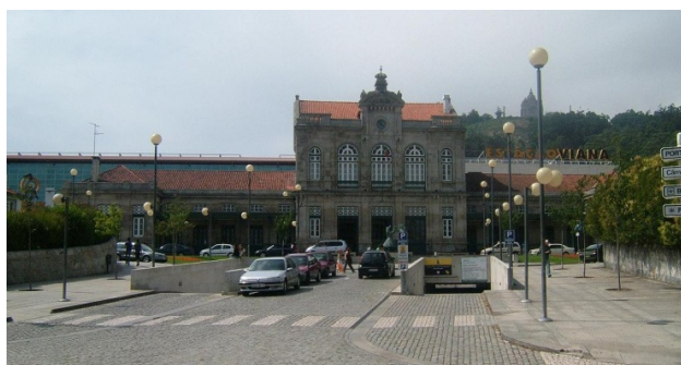
Figura 20 - Estado actual da estação do caminho-de-ferro
