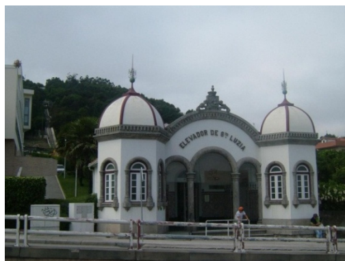
Figura 32 - Entrada do Elevador de Sta. Luzia
