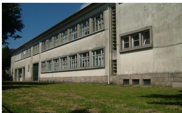
Figura 43 - Vista lateral do liceu
