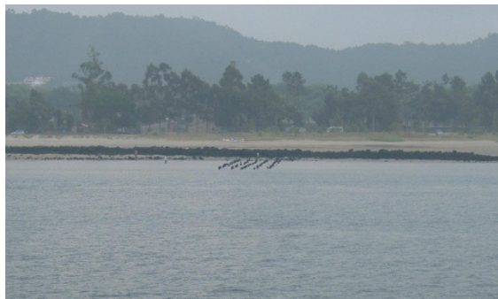
Figura 16 - Vestígios da Ponte de Madeira
