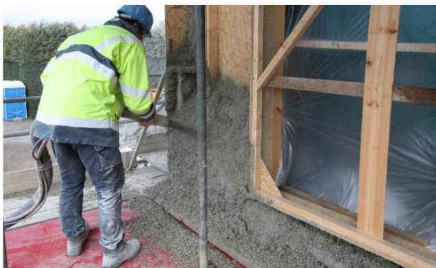
Figura IV. 9 - Exemplo do método de pulverização do betão de cânhamo (Mukherjee, 2012, p. 32)
