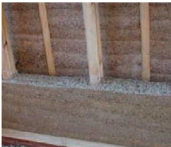
Figura V. 10 – Primeira camada de betão de cânhamo (Suffolk Housing Society, s.a)
