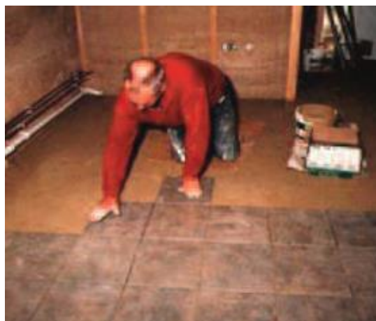
Figura V. 12 – Colocação da tijoleira sobre o betão de cânhamo e areia (Suffolk Housing Society, s.a)
