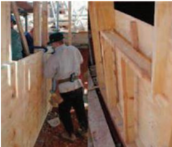
Figura V. 6 – Colocação das cofragens para a construção da parede (Suffolk Housing Society, s.a)
