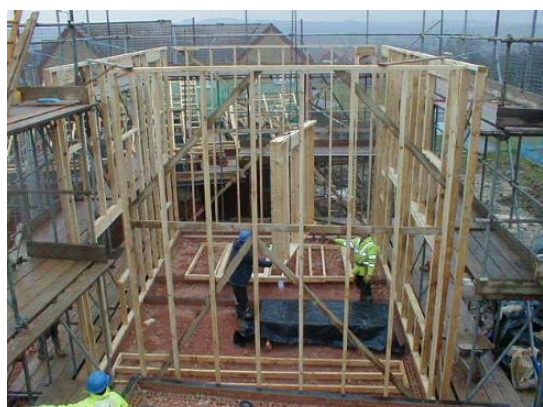
Figura V. 4 – Montagem da estrutura de madeira (Suffolk Housing Society, s.a)
