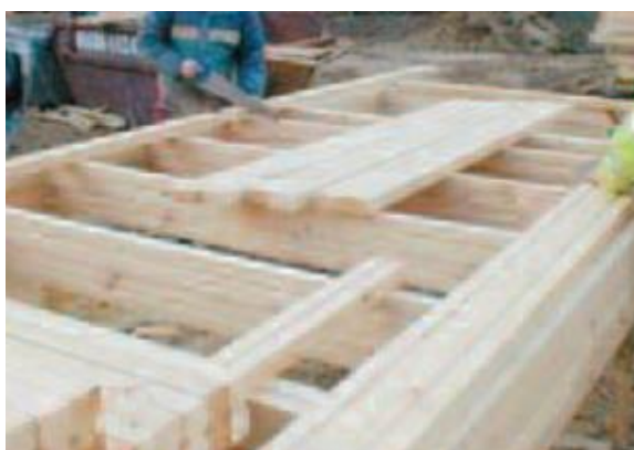
Figura V. 3 – Fabricação da estrutura de madeira (Suffolk Housing Society, s.a)
