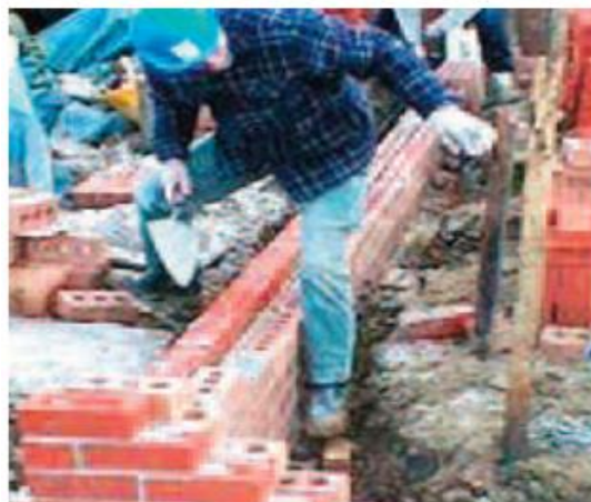
Figura V. 2 – Colocação de tijolo para finalizar as fundações (Suffolk Housing Society, s.a)
