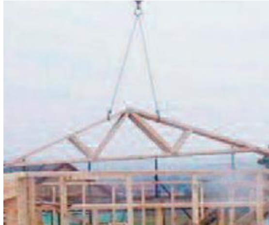
Figura V. 5 – Colocação das treliças do telhado (Suffolk Housing Society, s.a)
