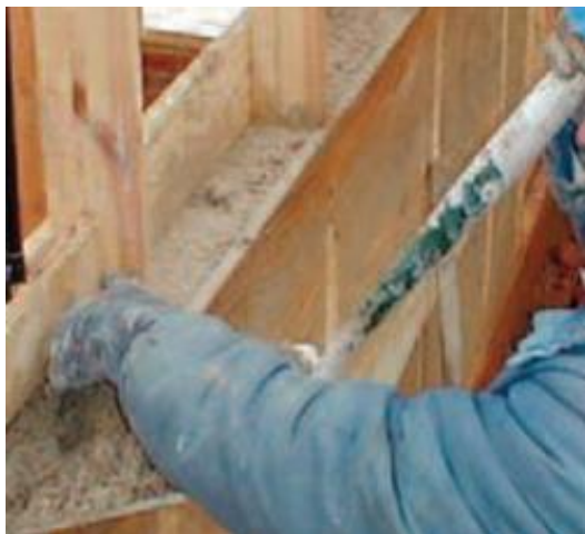
Figura V. 8 – Enchimento das cofragens com betão de cânhamo (Suffolk Housing Society, s.a)
