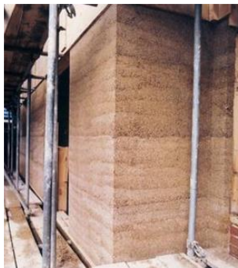
Figura V. 11 – Produto final após a remoção das cofragens (Suffolk Housing Society, s.a)
