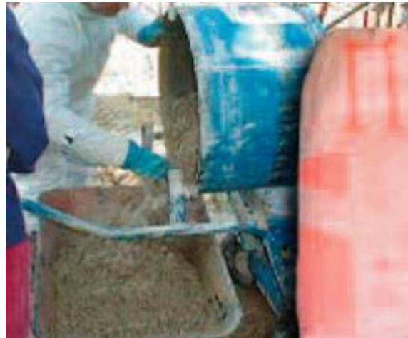
Figura V. 7 – Mistura do cânhamo com cal para obtenção do betão de cânhamo (Suffolk Housing Society, s.a)
