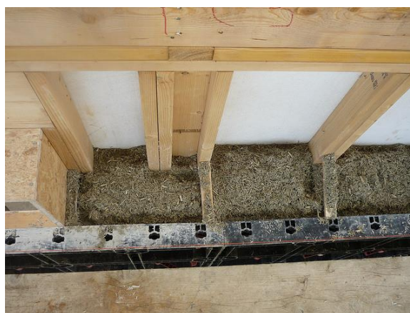
Figura IV. 8 - Exemplo do método de compactação do betão de cânhamo (Phillips, 2010)
