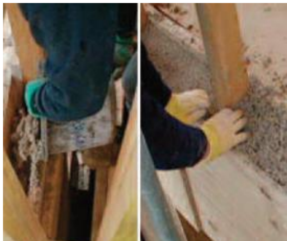
Figura V. 9 – Processo de compactação do betão de cânhamo (Suffolk Housing Society, s.a)
