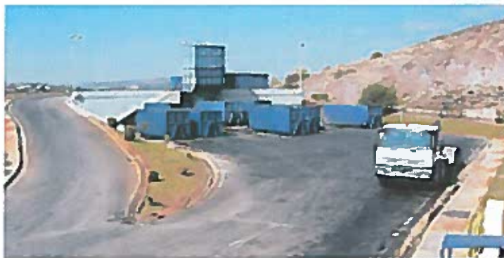
Figura I.2.6. – Estação de Transferência.
