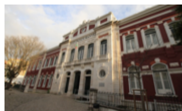
Figuras 1 – Vista da fachada principal do Liceu Passos Manuel, Lisboa. Fonte: www.passosmanuel.pt
