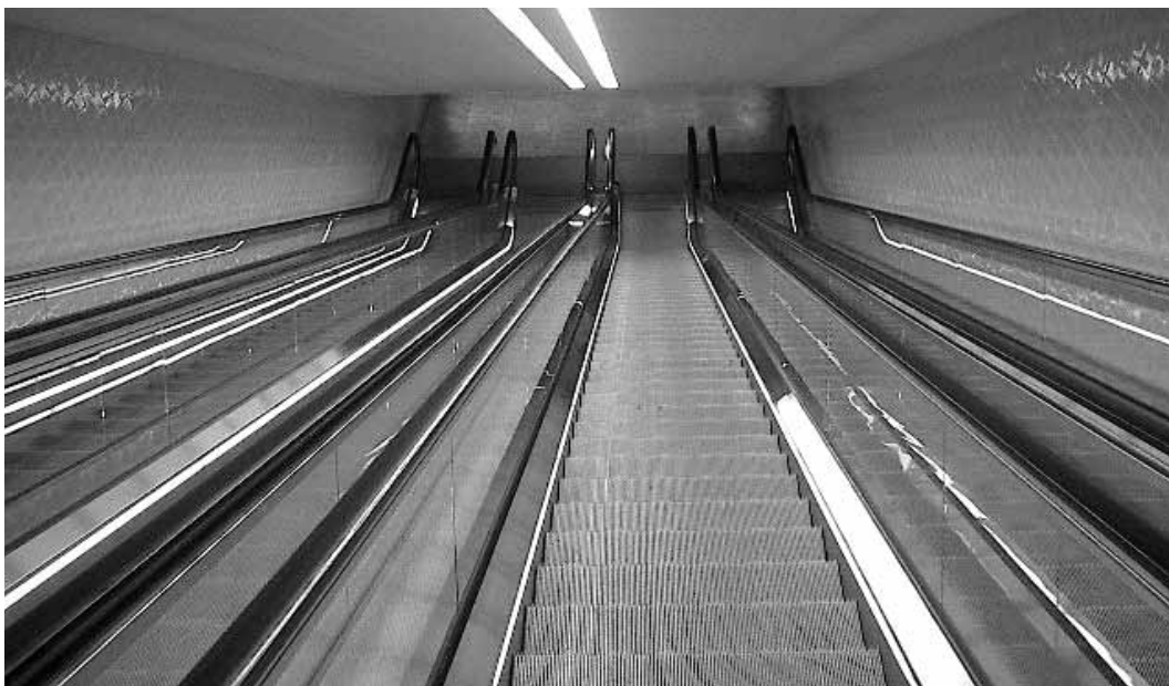
FIGURA 8. TUNEL DE ACESSO AO CAIS DE EMBARQUE
