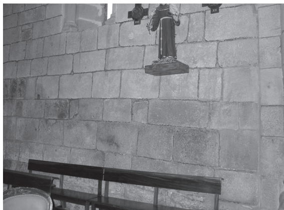
FOTO 1 E 2 Aspecto do aparelho da parede que pode indicar uma ampliação da capela-mor e inclinação das fiadas da parede Sul da capela-mor e fiadas de pedra irregular no arranque da mesma
