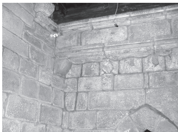
FOTO 4 Modilhões internos ao nível do actual coro visíveis da parede da torre, que terão servido de suporte à galilé
