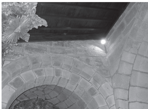
FOTO 3 Fiadas de remate da água da cobertura, evidenciando a transformação da cobertura de duas águas num telhado de uma água
