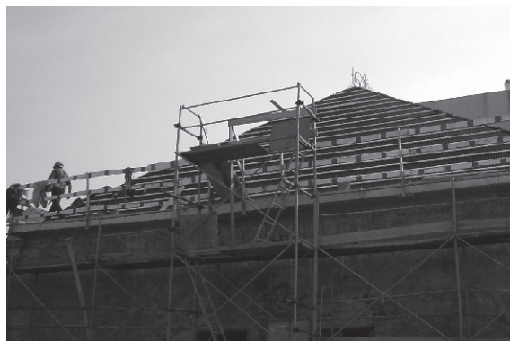
FOTO 3 Reconstrução dos telhados e recuperação das paredes
