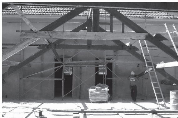
FOTO 2 Re-colocação das asnas, depois de trabalho de recuperação
