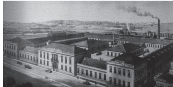
FOTO 1 Fotografia do edifício da EICHAP ainda completo. Apenas resta o corpo voltado à rua.
