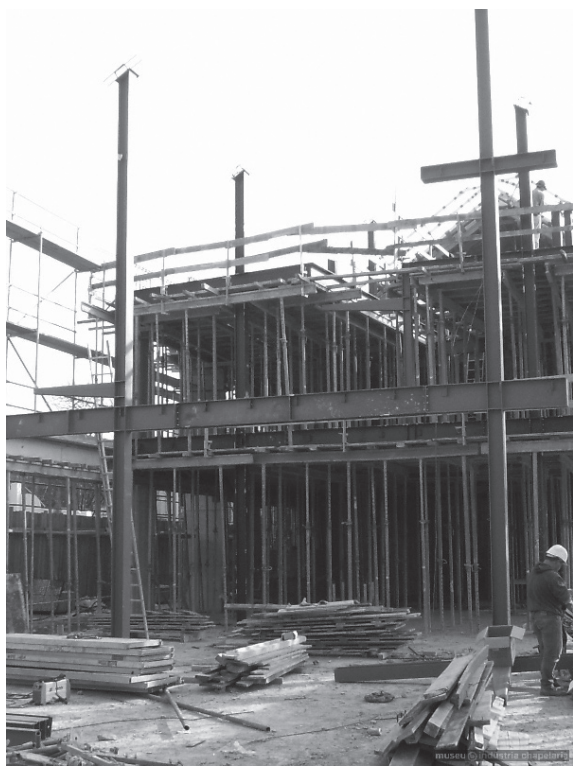
FOTO 4 Colocação da estrutura interna do novo edifício
