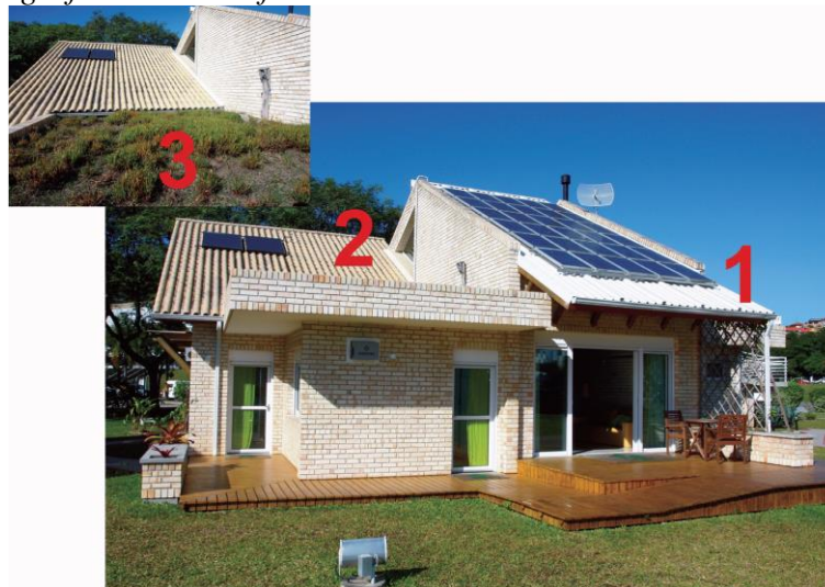
Figura 2 - Fotografia da Casa Eficiente
