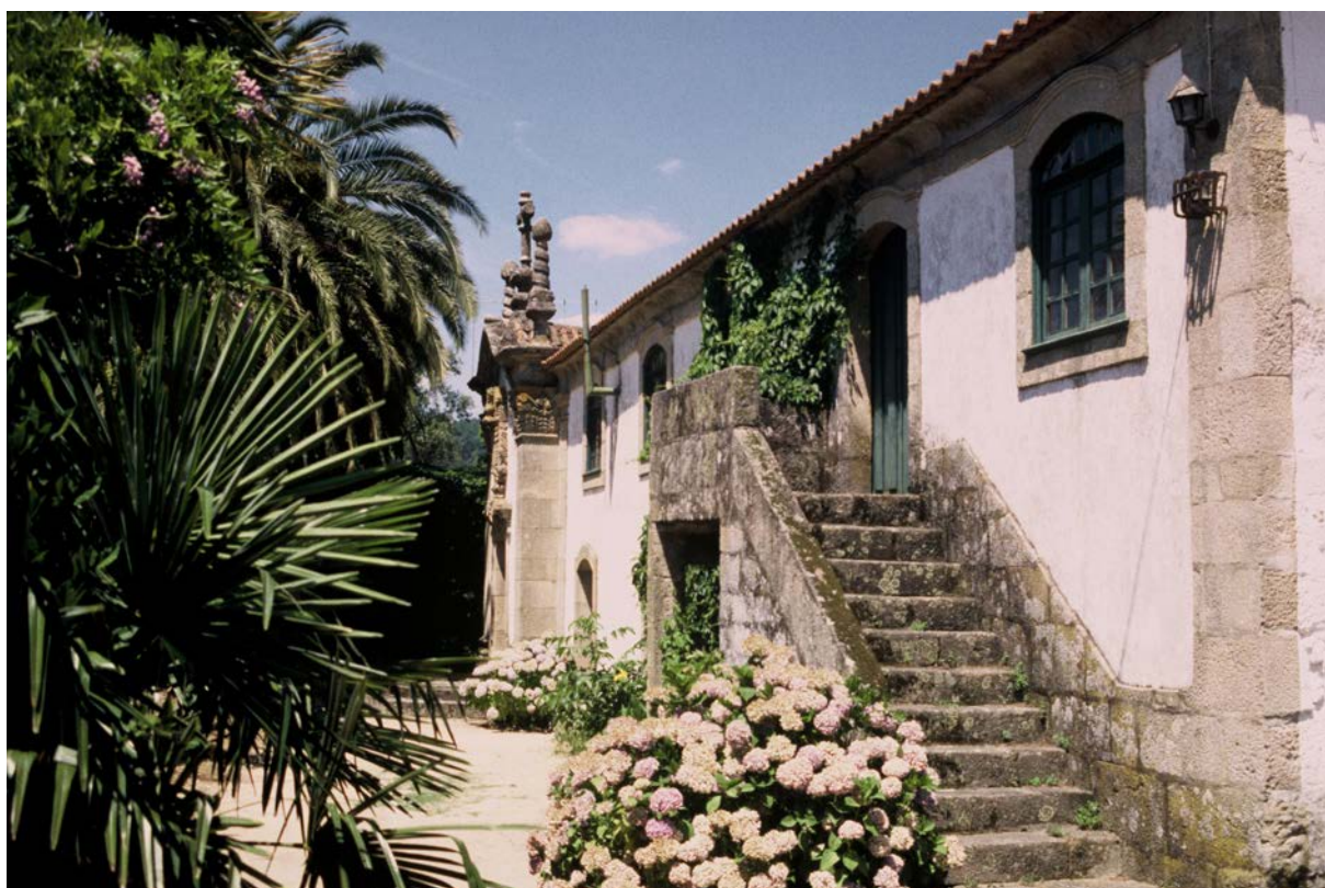
Figura 4. Alçado Sul, Casa do Fundo da Rua. Fotografia de Ricardo Soares.
