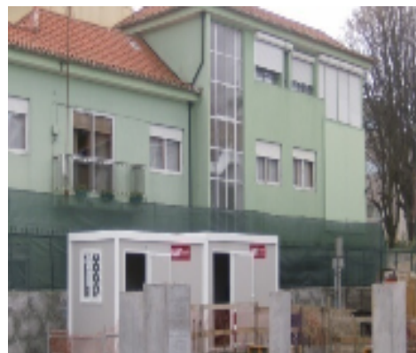
Figura II.5. Vedação da parte traseira da Obra
