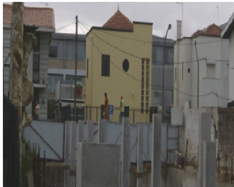
Figura II.6. Vedação da parte frontal da Obra
