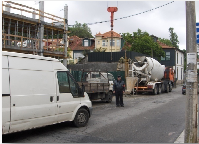
Figura II.7. Restrições de circulação motivadas por operação de betonagem
