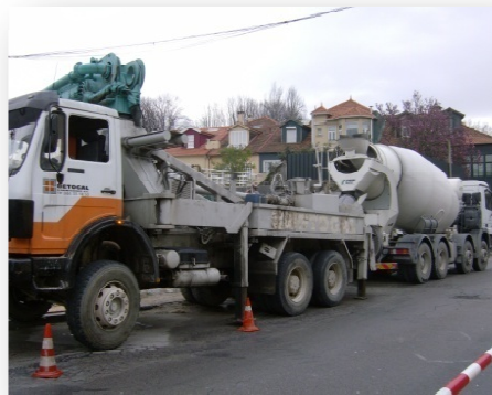
Figura I.3. Camião de betão e bomba
