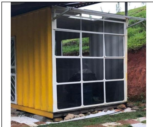
Figura 18: Parede feita com vidro de ônibus
